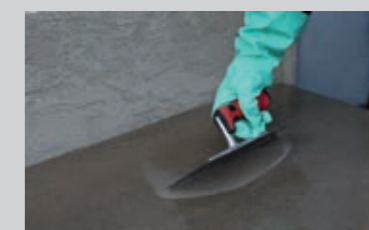
Die porenfreie Kratzspachtelung bestehend aus PCI PUR-Grund abgemischt mit Quarzsand 0,06 – 0,30 ermöglicht eine sichere Haftung und eine blasenfreie Aushärtung der nachfolgenden Beschichtung
