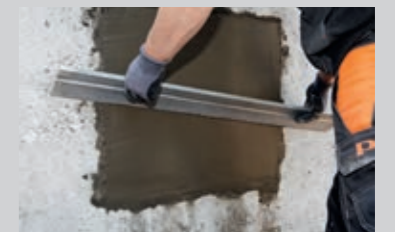
Die Reparaturflächen bündig abziehen und nach kurzer Wartezeit glätten bzw. abfilzen
