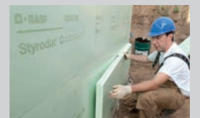
PCI Pecimor® DK vollflächig auf die Dämmplatte auftragen und verkleben. Oberhalb des Grundwasserspiegels ist auch eine Verklebung im Punktklebeverfahren zulässig. Die Stöße der einzelnen Platten mit PCI Pecimor® DK verspachteln
