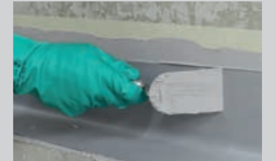
Das Abdichtungsband PCI Pecitape® 3000 sorgfältig andrücken und mit einer Kelle glattstreichen
