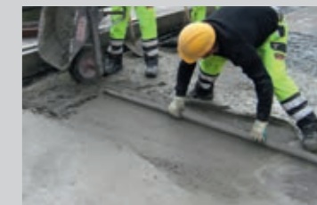
Standfester Ausgleich einer Bodenfläche aus Beton mit PCI Repafast® Tixo
