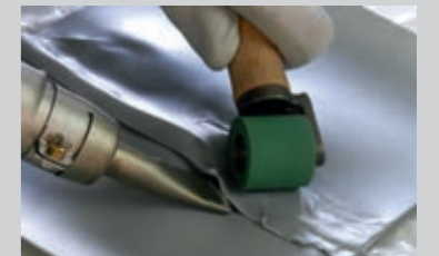
Die Verschweißung von Abdichtungsbandern und das Verkleben von Übereckverbindungen erfolgt mittels Heißluftpistole. Die Dehnfähigkeit muss gewährleistet sein
