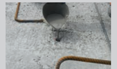
Verfüllen von Bohrlöchern mit PCI Polyfix® 5 min.
