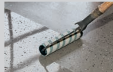
Aufbringen einer UV-stabilen Kopfversiegelung, z. B. PCI Finopur®
