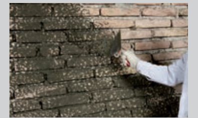
Aufbringen eines Spritzbewerfs vergütet mit PCI Emulsion
