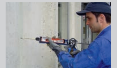
Verfüllen sowie Fixieren von Verankerungen mit Methacrylat PCI Barrafix® 920
