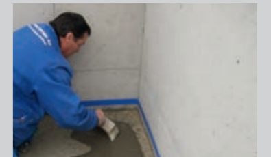
Bei Verbundestrichen ist eine Haftbrücke aus PCI Repahaft® aufzubringen
