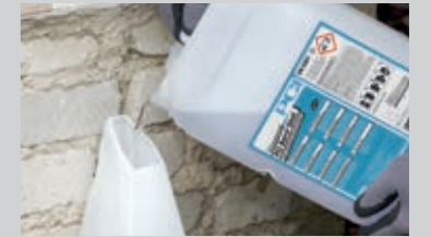
Mauerwerk mit der flüssigen Horizontalabdichtung PCI Barra® Gisol gegen aufsteigende Feuchtigkeit schützen
