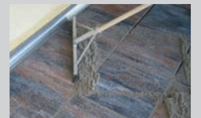
Einbringen des drainfähigen Pflasterfugenmörtels PCI Pavifix® 1K Extra auf der vorgemasteten Natursteinfläche
