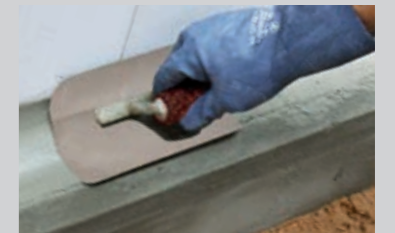
Ausbilden einer Dichtungs-/Hohlkehle am Übergang mit PCI Polyfix® plus L
