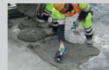
Standfester Bodenausgleich eines Betonausbruchs mit PCI Repafast® Tixo
