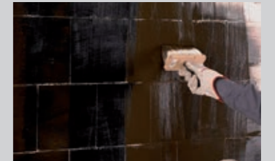
Grundierung je nach Witterung mit PCI BT 26 oder PCI BT 28
