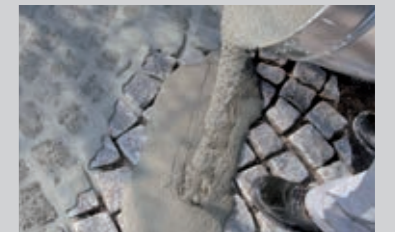
Einbringen des drainfähigen Pflasterfugenmörtels PCI Pavifix® 1K Extra auf der vorgemasteten Natursteinfläche
