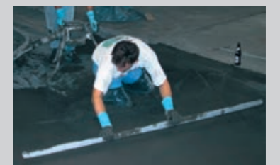
Estriche auf Dämm- und Trennlagen sind in homogenen Schichtdicken aufzubringen
