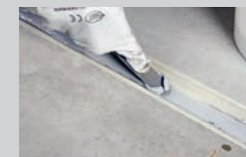
Abstreifen des überschüssigen Fugematerials und Glätten
