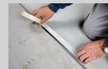
Abkleben der Fugenkanten
