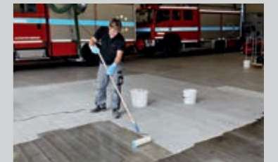
Grundieren der vorbereiteten Fläche mit Epoxidharz wie z. B. PCI Epoxigrund 390
