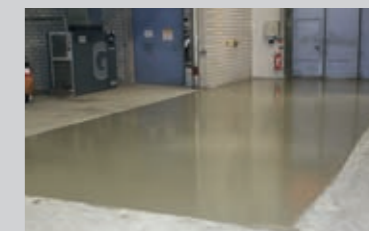
Ausgleich eines Betonbodens mit leichtverlaufendem Fließestrich PCI Zemtec® 180
