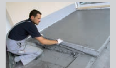
Mit Zusatzmitteln wie PCI Estrifix® und PCI Dichtungsmörtel werden die Verarbeitung und die Eigenschaften von herkömmlichen zementären Estrichen verbessert
