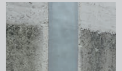
Abdichten von zwei Fertigbauteilen mit PCI Pecitape® 3000
