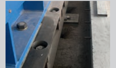
Schalung erstellen, Material gleichmäßig von einer Seite in die Schalung eingießen, damit Luft vollständig entweichen kann
