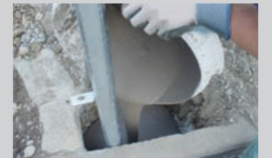
Fixieren von Einbauteilen mit zementärem PCI Repaflow® Turbo
