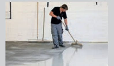
Verteilen mit Rakel und Stachelwalze
