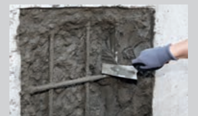
Kontaktschicht mit der ersten Lage Reparaturmörtel aufstreichen oder mit der Traufel aufkratzen
