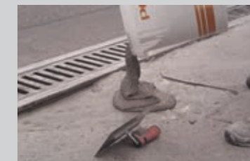
Fließfähiger Ausgleich einer Bodenfläche aus Beton mit PCI Repafast® Fluid
