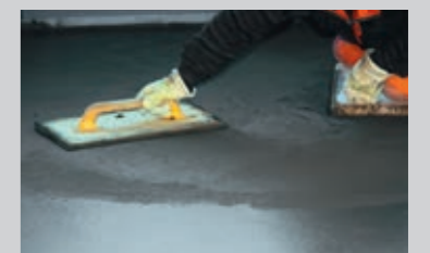
Gegebenenfalls ist unterhalb der Trennlage ein Ausgleich im Verbund aufzubringen
