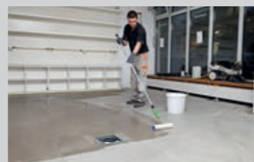
Nach ca. 1 Tag können die zementären Bodenausgleichsmassen mit einer Kopfversiegelung, z. B. PCI Zemtec® Top, versiegelt werden
