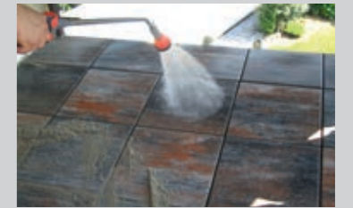
Einbau des Monokornmörtels PCI Pavifix® DM auf eine unterstützende Drainmatte
