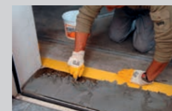
Ausgleich einer Schwelle oder Treppenstufe mit standfestem Epoxi-Mörtel PCI Aposan®
