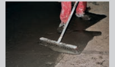
Aufbringen einer Mörtelhaftbrücke mit PCI Pecihaft®
