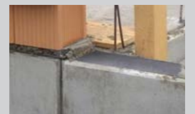
PCI Barraseal® Turbo als als Horizontal-sperre unter Wänden
