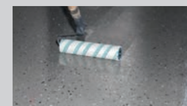
Die eingestreuten Farbchips müssen mit PCI Pursol® transparent versiegelt werden. Bei Beschichtungen ohne Farbchips kann die 2. Lage mit PCI Pursol® 1K farbig erfolgen.
