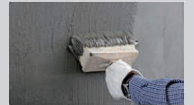
Aufbringen der mineralischen, sulfatbeständigen Abdichtung PCI Barraseal®
