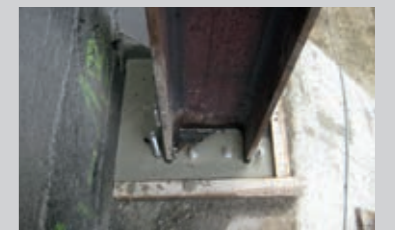
Verguss einer Stütze mit PCI Repaflow®
