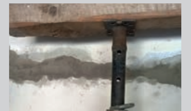
Schwindfreies Ausfüllen von Spalten mit PCI Repaflow® USM.
