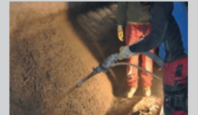
Der sulfatbeständige Reparaturmörtel PCI Nanocret® R4 PCC kann sowohl händisch als auch maschinell aufgetragen werden
