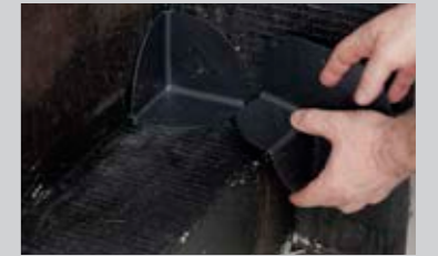
Kritische Ecken sicher absichten mit PVC-Formteilen PCI BT 45 und PCI BT 46
