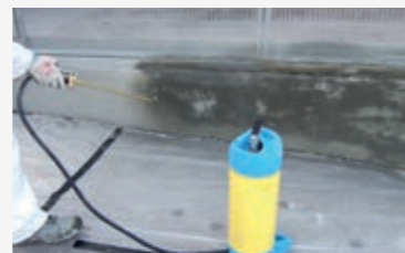
Manueller Auftrag einer PCI Silconal®-Hydrophobierung als nicht filmbildende wasser- und schmutzabweisende Maßnahme
