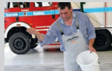
Einstreuen von Farbchips in die noch frische Beschichtung
