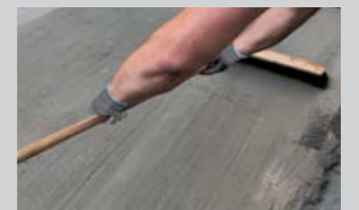
Ausführung eines Besenstrichs auf PCI Peciment® 50
