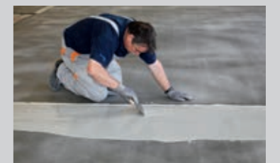
Händisches Anarbeiten an eine Dehnfuge
