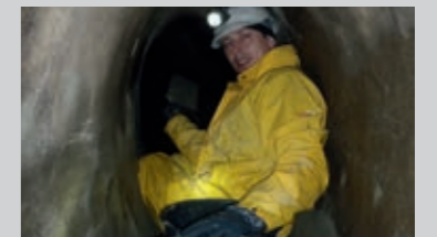
Aufbringen der sulfatbeständigen Dichtschlämme PCI Barraseal® im Bereich von Abwässern
