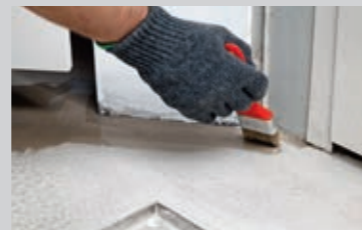
Händischer Auftrag der mattierenden Kopfversiegelung PCI Finopur®
