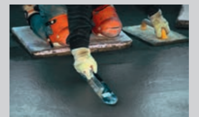
Estriche oberflächlich mit einer Traufel oder einem Flügelglätter glätten
