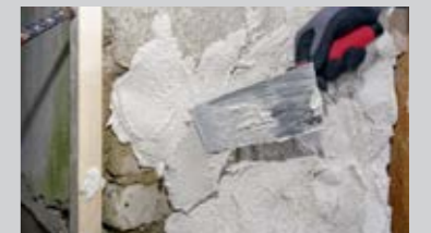
Aufbringen von PCI Saniment® 2 in 1 als Sanierputz und Feinputz in einem
