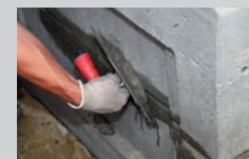
Schließen von Fugen und Angarnieren von Ecken und Kanten mit PCI Nanocret® R2
