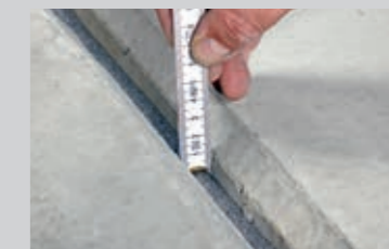
Auf die erforderliche Fugentiefe achten (mind. 10 mm)
