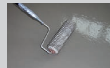
Das Material gleichmäßig verteilen und mit einer Stachelwalze entlüften
