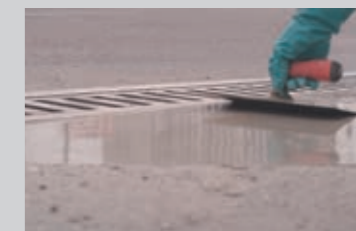
Anarbeiten an eine Rinne mit dem Epoxi-Vergussmörtel PCI Repaflow® EP Plus
