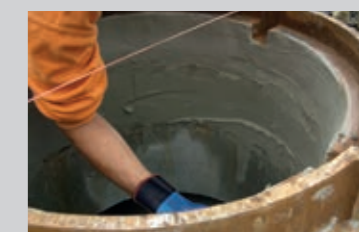
Anputzen und Setzen eines Schachtrings mit PCI Polyfix® plus L
