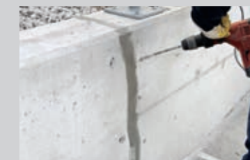
Bauteil schräg zum Rissverlauf abwechselnd rechts und links anbohren. Das Bohrloch muss den Riss etwa in der Mitte überschneiden
