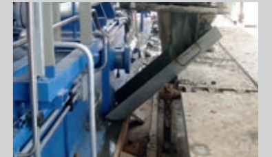
Material bis zum Überlauf auf der gegenüberliegenden Seite verfüllen
