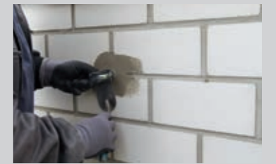
Setzen von Muffen und Verankern von Einbauteilen mit Hilfe von zementären Mörteln wie z. B. PCI Repafix®
