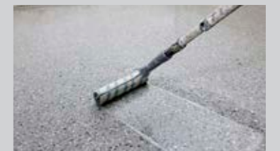
Optional PCI Farbchips einstreuen und dekorativ gestaltete Fläche mit PCI Finopur® lichteucht und seidenmatt versiegeln.
