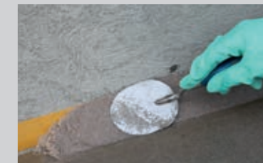
Erstellen einer Hohlkehle aus PCI Bauharz abgemischt mit Quarzsand
