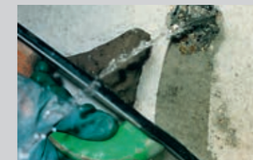
PCI Polyfix® 30 sek. als Blitz-Zement-Mörtel zum schnellen Abdichten von Wassereintrüben
