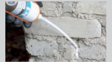
Injektion einer wasserabweisenden Horizontalsperre mit PCI Barra® Creme
