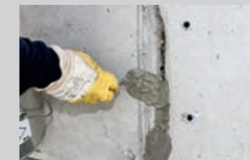
Risse und Klüfte sorgfältig mit Mörtel verschließen (ggf. zuvor aufweiten)
