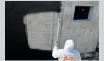
Grundierung eines saugfähigen Untergrunds mit PCI Pecimor® F
