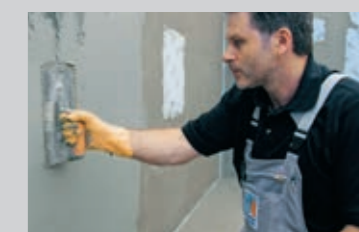
Aufbringen der schnellabbindenden, rissüberbrückenden und UV-beständigen Abdichtung PCI Barraseal® Turbo in einem Wasserbecken
