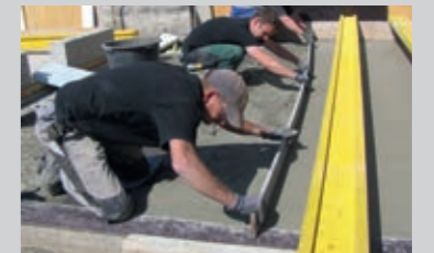
PCI Peciment® 50 auf einer Brücke nach ZTV-ING
