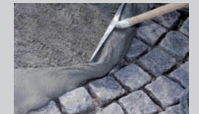
Einbringen des zementären Pflasterfugenmörtels PCI Pavifix® CEM auf eine vorgemastete Pflastersteinfläche
