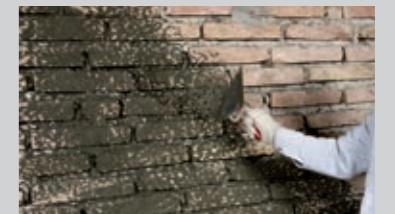
Im Sanierputzsystem wird der Spritzbewurf PCI Saniment® HA netzförmig mit einem Deckungsgrad von ca. 50 Prozent aufgebracht
