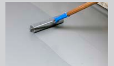
Nach zweimaligem Streichen mit PCI Supracolor ist die optische Sanierung abgeschlossen.
