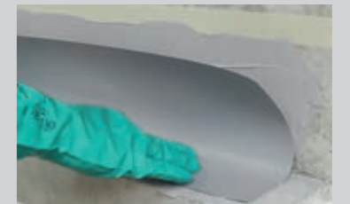
Den Epoxi-Baukleber PCI Barrafix® EP gleichmäßig auftragen und das Abdichtungsband PCI Pecitape® 3000 einlegen
