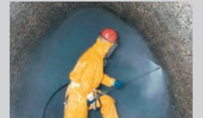
Vorbereiten einer geschädigten Betonoberfläche in einem Kanal
