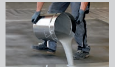
Aufbringen der Verlaufsbeschichtung
