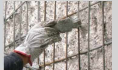
Vorbehandlung der Bewehrungsstäbe mit dem aktiv ausgestatteten Bewehrungsschutz PCI Nanocret® AP
