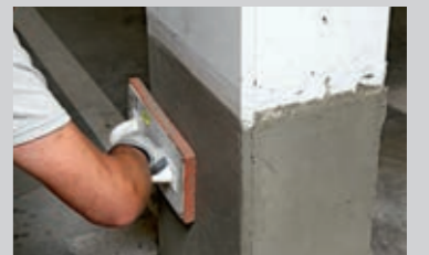
Schließen von Lunkern mit dem Feinspachtel PCI Nanocret® FC
