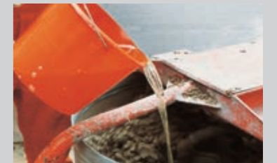
Aufbringen eines Spritzbewerfs vergütet mit PCI Emulsion
