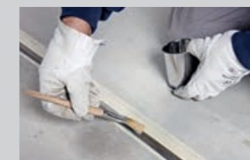
Primern der Fugenflächen und Abluftzeiten beachten. Hier: PCI Elastoprimer 110 bei saugenden Untergründen ca. 60 Minuten. Auf gleichmäßiges Einbringen des Fugendichtstoffs achten
