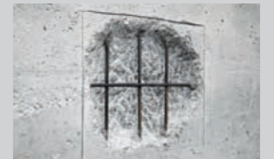
Die Bewehrungsstäbe von Rost und Altanstrichen befreien
