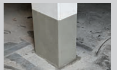
Mit dem Feinspachtel PCI Nanocret® FC überarbeitete Stütze
