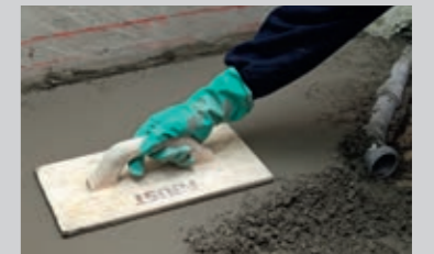
Der PCI Novoment® Schnellestrich muss frisch in frisch auf die Haftbrücke aufgebracht werden
