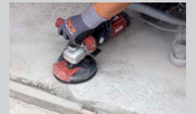
Alte Rückstände und Verunreinigungen durch Abschleifen entfernen.
