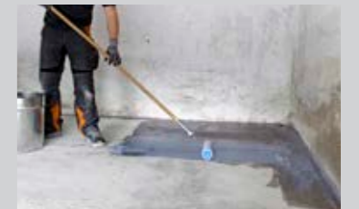
Zweimaliges Grundieren mit PCI Gisogrund® 404 (im Kreuzgang sorgt für eine sichere Haftung des Bodenausgleichs auf dem Untergrund).
