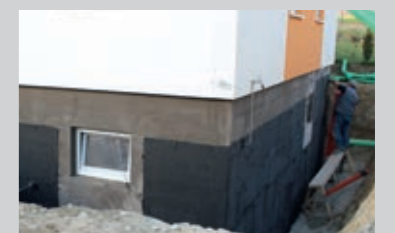
Übergang einer Schwarzabdichtung mit PCI Barraseal® Turbo über die Geländeoberkante
