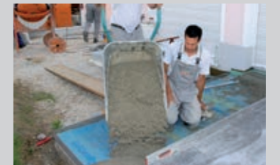
Einbau des Monokornmörtels PCI Pavifix® DM auf eine unterstützende Drainmatte
