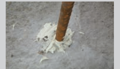
Verfüllen von Bohrlöchern mit PCI Polyfix® 5 min.
