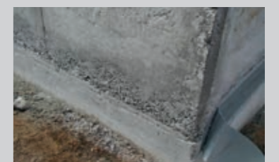
Abdichten einer Konstruktionsfuge mit PCI Pecitape® 3000
