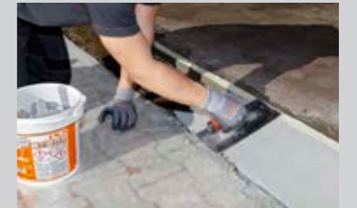
Aufbringen von PCI Aposan® zum Überbrücken von Höhenunterschieden bis 50 mm.
