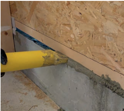
Unterfüllen von Holzständerkonstruktionen mit PCI Repaflow® USM
