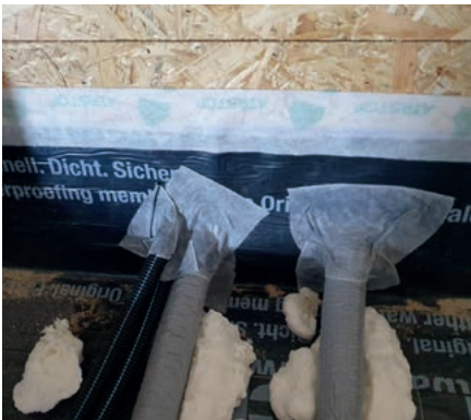
Wasserdampfsperrendes Abdichten unter Estrichen
