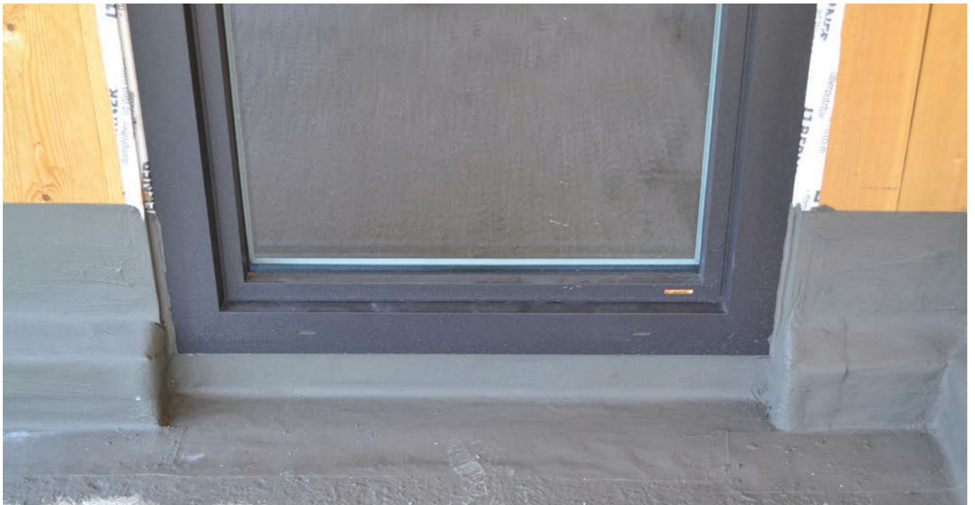
Mit Pectitape® 250 in Verbindung mit PCI Barraseal® Turbo abgedichtete Laibungsflächen sind leicht überputzbar und haftungsfreundlich (Richtlinie Sockelanschluss im Holzhausbau)
