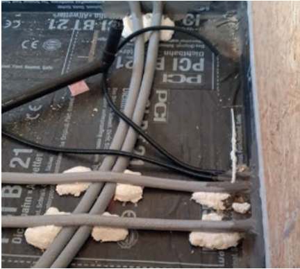
Leitungen direkt auf der Abdichtungsbahn fixieren
