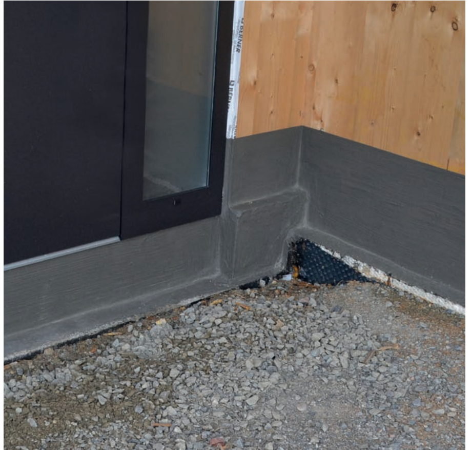
Anarbeiten der flexiblen mineralischen Dichtschlämme PCI Barraseal® Turbo an das PCI-Dichtband und Fensterelement
