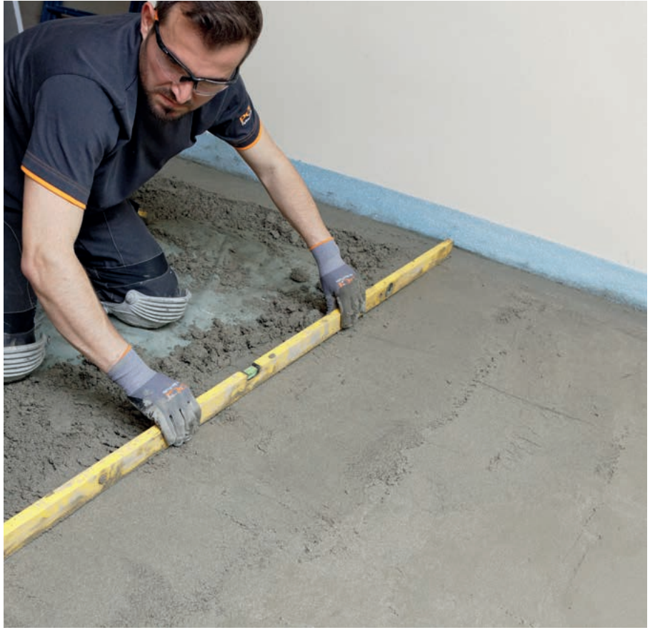
Zusätzliches Glätten der Oberfläche ist nach Abziehen und Abreiben kaum mehr erforderlich
