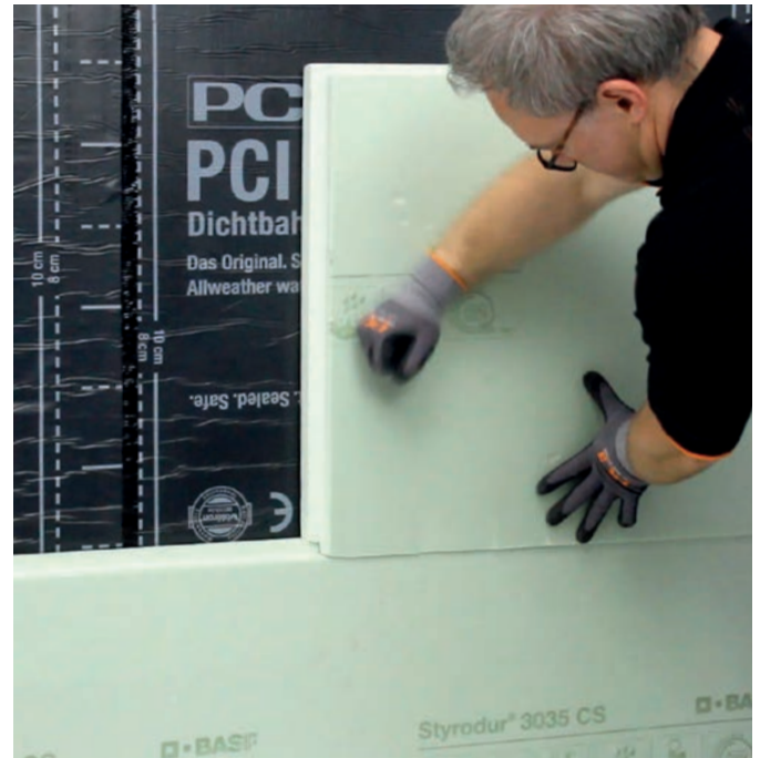
PCI Barraseal® Turbo zur Verklebung von Dämmplatten auf KSK-Bahnen, Holz oder MDS-Abdichtungen.
