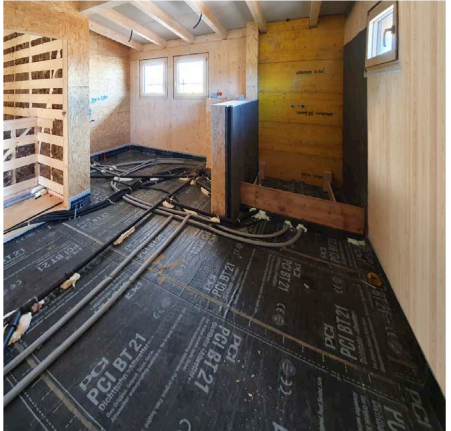
Abdichtung gegen kapillaraufsteigende Feuchtigkeit und als Wasserdampfbremse unter Estrichen
