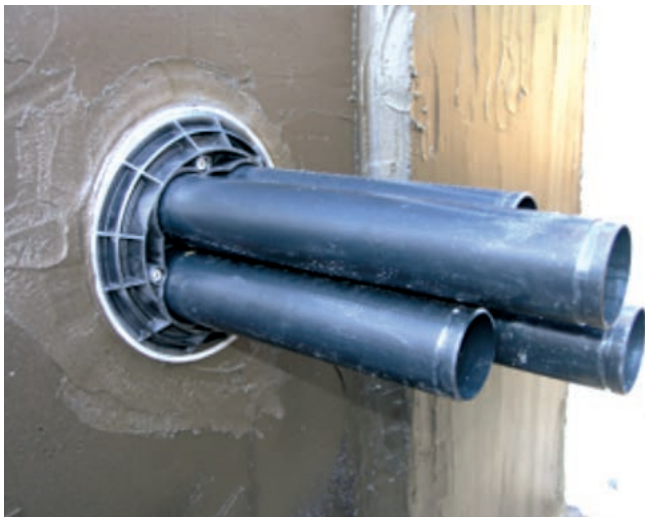
Anarbeiten von PCI Barraseal® Turbo an eine Mehrspartenhauseinführung
