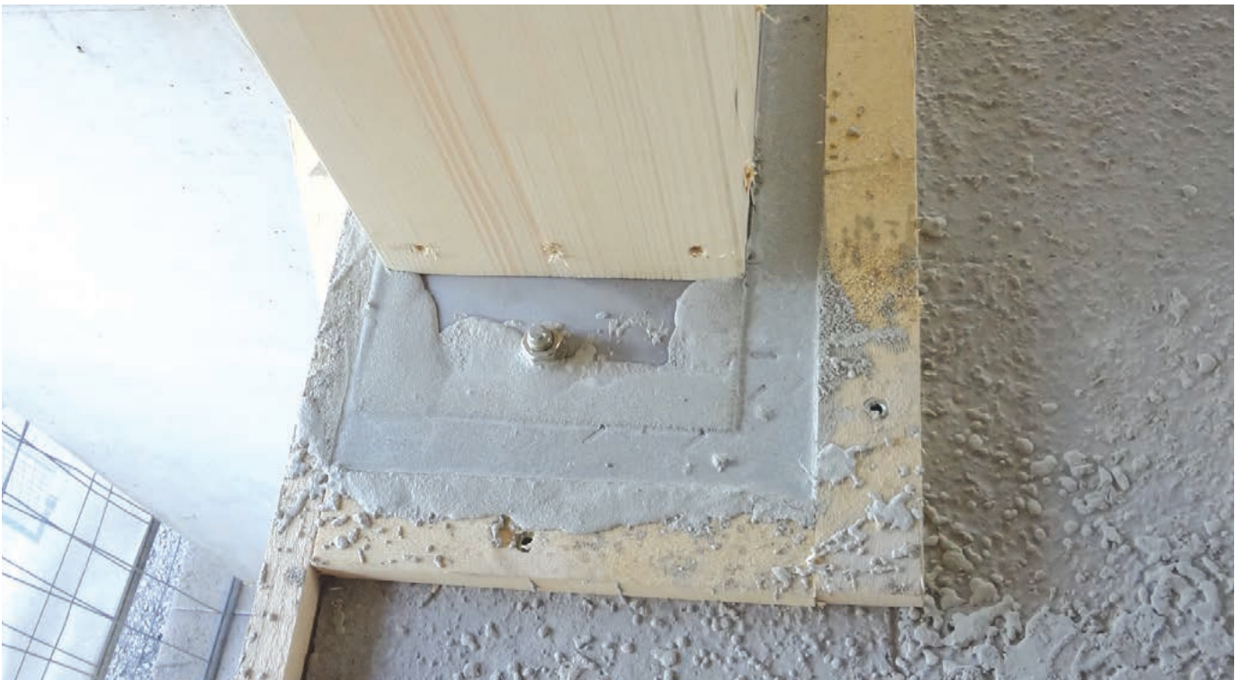
Fertig vergossener Stützfeiler
