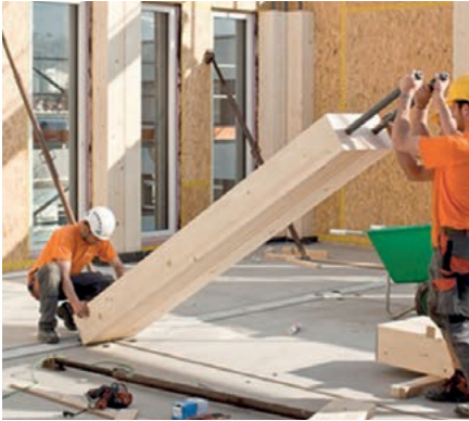
Stützfeiler aufrichten und in der Senkrechten fixieren
