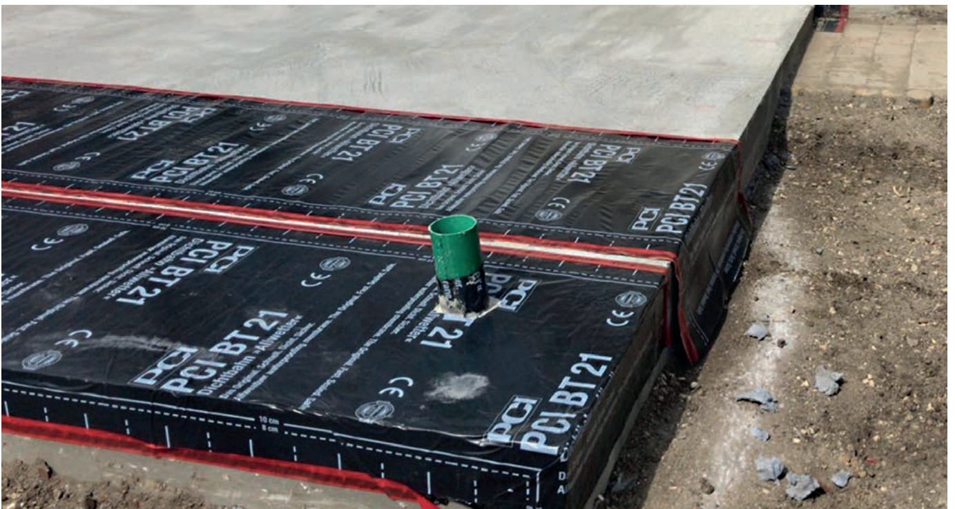
Betonbodenplatte wasserdampfsperrend mit PCI BT 21 abdichten
