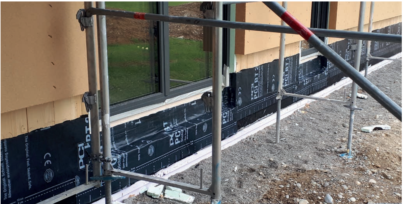
Abdichtung bodentiefer Fenster bzw. Fußpunkten/Kanten oder Sockeln mit PCI BT 21 nach DIN 18533-2. Sofort wasser- und schlagregendicht – das Gelände kann sofort und ohne Verzögerung verfüllt werden
