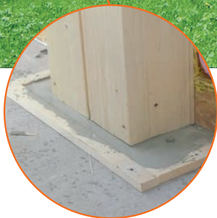
Kraftschlüssiger Verguss von tragenden Teilen
