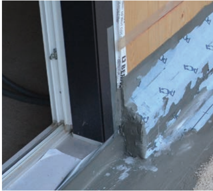
Einbetten von PCI Pectitape® 250 in das frische PCI Barraseal® Turbo
