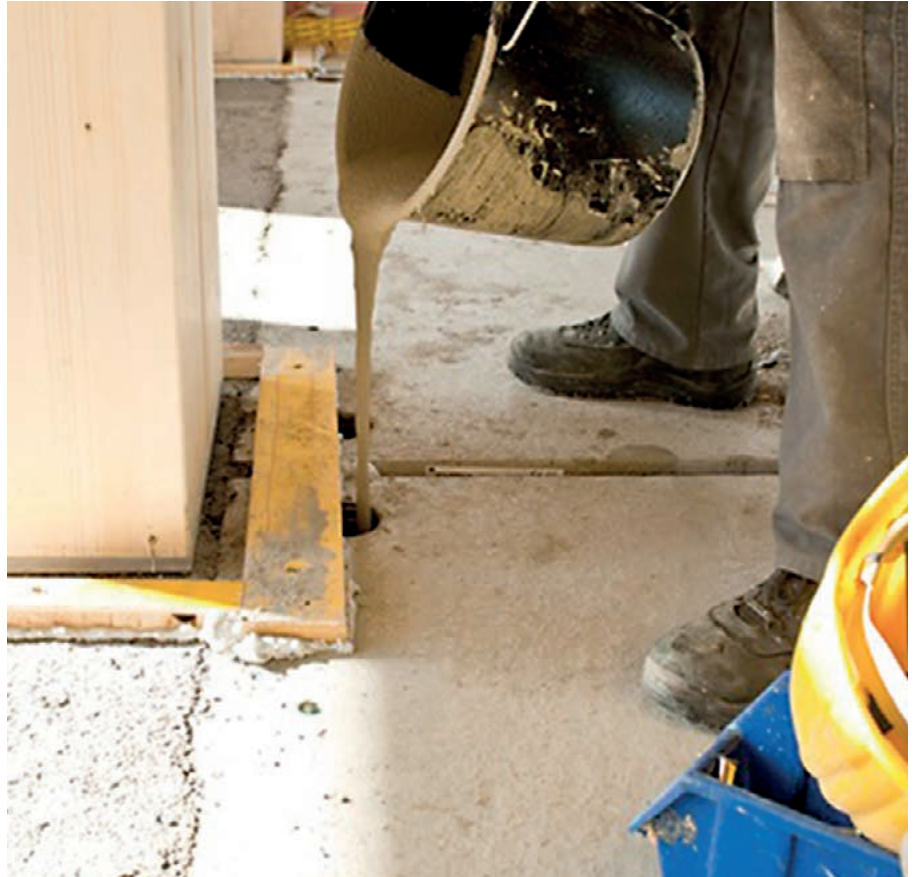
Nur ein sicherer, kraftschlüssiger Verguss z.B. mit PCI Repaflow® garantiert das Erreichen der gewünschten Stabilität
