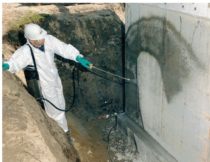
Abb. 4 – Grundierung durch Spezial-Grundierung PCI Pecimor®-Betongrund.
