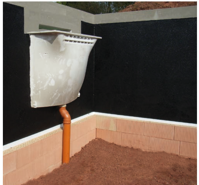
Abb. 11 – Fachgerechte Ausführung einer Abdichtung mit lagenweiser Anfüllung des Bodens.
