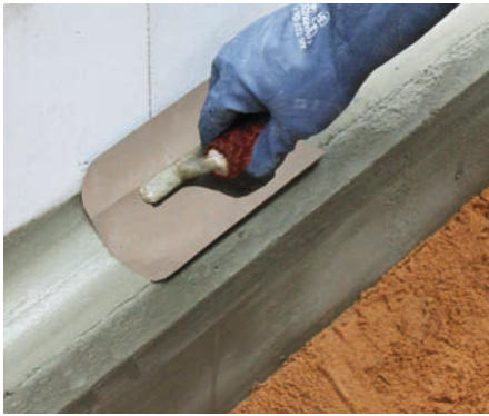
Abb. 1 – Fehlstellen ausbessern und Dichtungskehlen erstellen mit nichtkapillar wasserleitfähigem PCI Polyfix® plus L.
