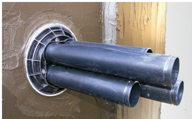
Abb. 9 – Mehrspartenrohrdurchführung.
