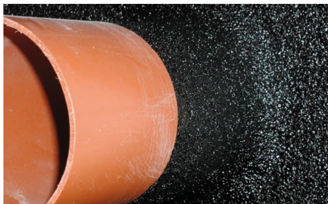
Abb. 8 – Rohrdurchführung.
