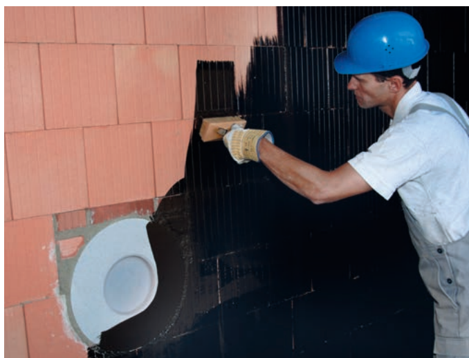
Abb. 3 – Grundierung durch Bitumen-Grundierung PCI Pecimor® F, 1:5 mit Wasser.
