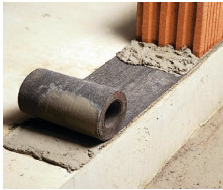
Abb. 2a + 2b – Darstellung der derzeitigen und zukünftigen Ausbildung einer Horizontalabdichtung im Mauerwerk.
