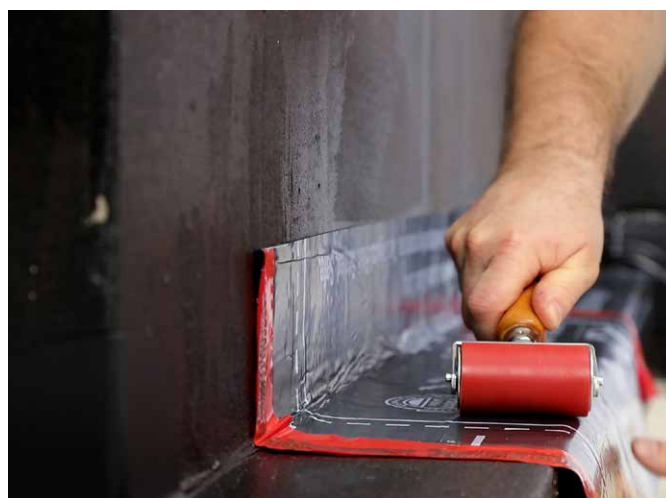
Einfach ankleben: Sauberes, schnelles Verarbeiten zeichnet PCI BT 21 aus. Auch Ecken und Unebenheiten lassen sich mit der Dichtbahn einfach ausführen.
