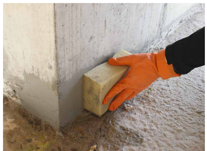
Der Feinspachtel PCI Barrafill® L eignet sich insbesondere für vollflächige Kosmetikarbeiten an Betonbauteilen.
