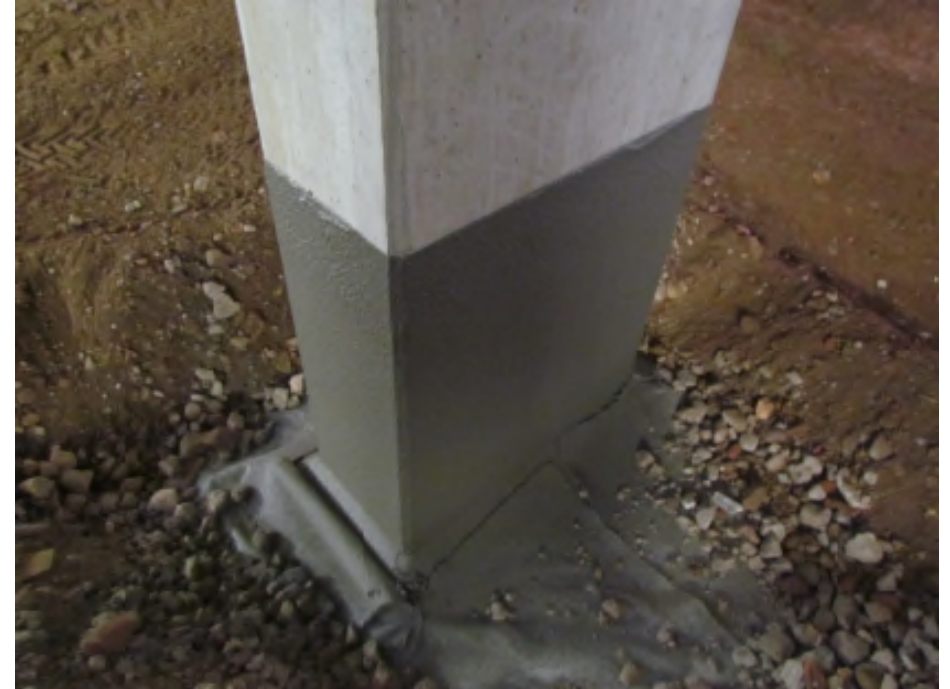
Stützenabdichtung
