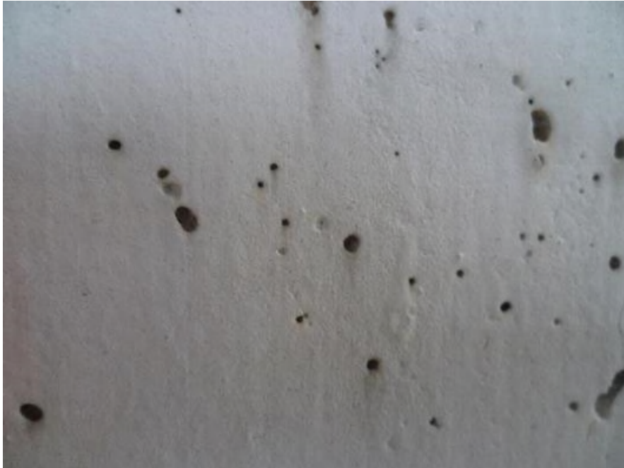
sichtbare Oberflächenporigkeit
