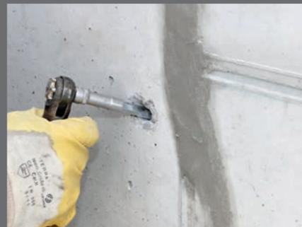
Bohrloch reinigen und PCI Apogel® Tagespacker fest eindrehen
