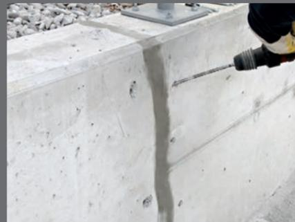
Bauteil schräg zum Rissverlauf abwechselnd links und rechts anbohren, wobei das Bohrloch den Riss etwa in der Mitte überschneidet
