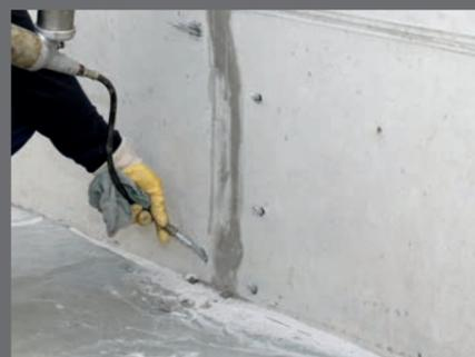
Injektionsharz, beginnend mit dem untersten Bohrloch, bis zur vollständigen Sättigung injizieren
