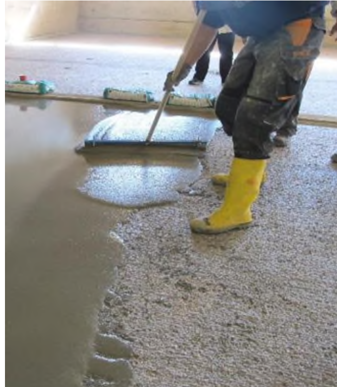
Ausgleich auf Grundierung einbringen
