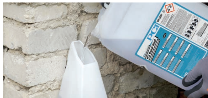
Mauerwerk mit der flüssigen Horizontalabdichtung PCI Barra® Gisol gegen aufsteigende Feuchtigkeit schützen
