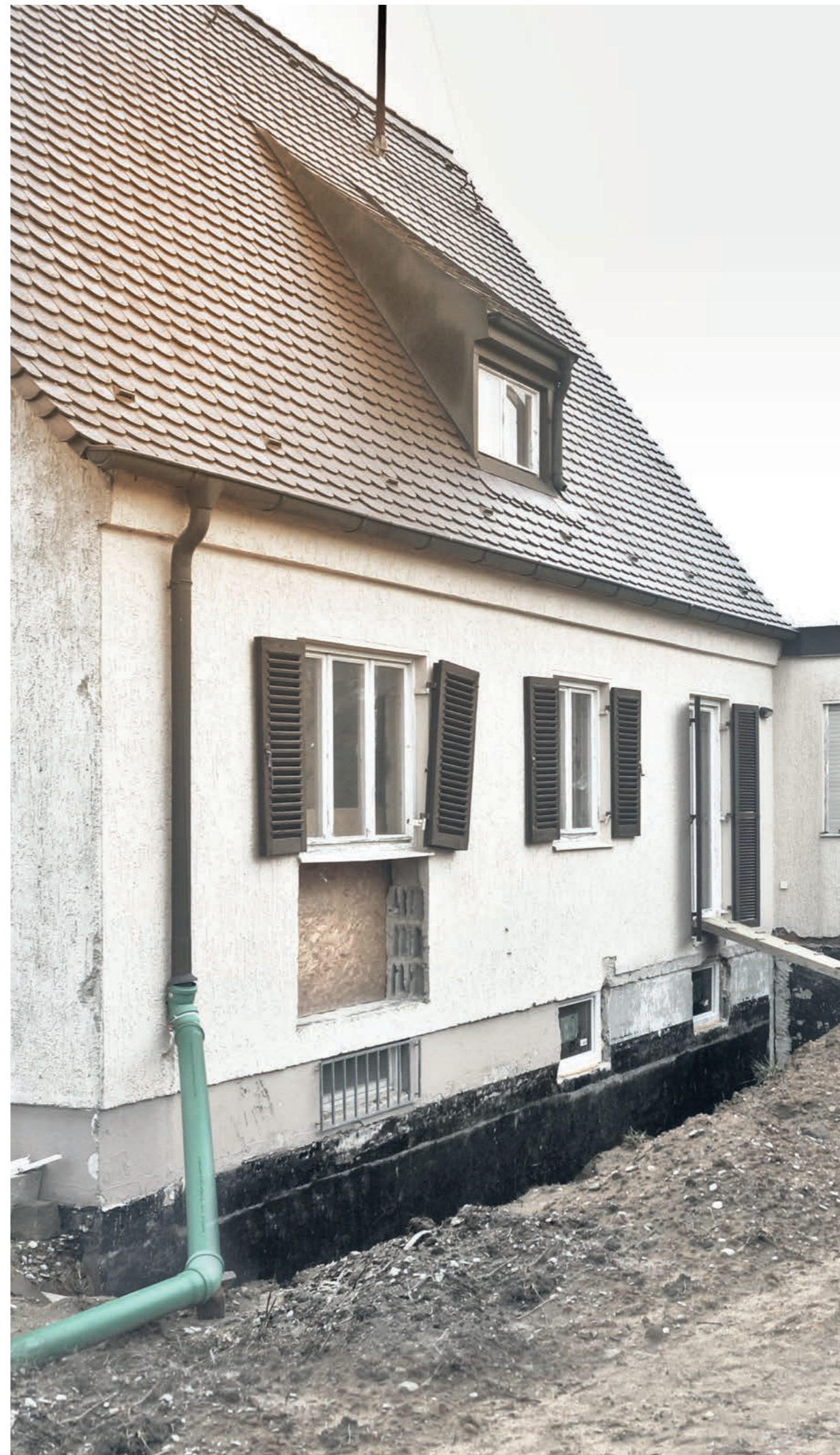
System Bauwerksabdichtung PCI Pecimor®
