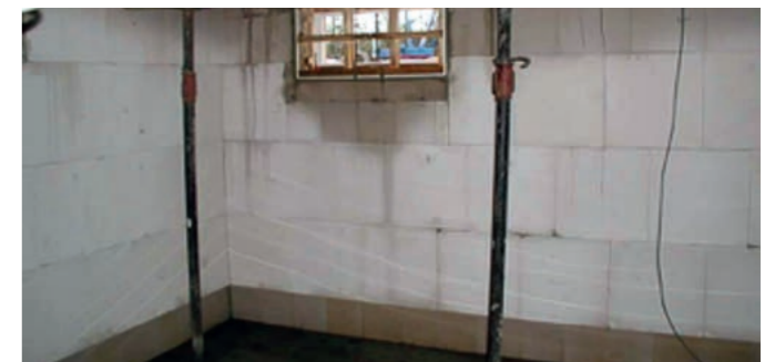
Durchfeuchtetes Kellermauerwerk
