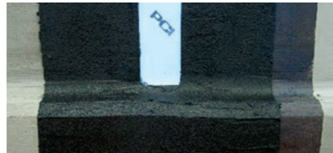
Abdichtung PCI Pecimor® 1K/2K, Dichtband PCI Pecitape® 250, Grundierung PCI Pecimor® F
