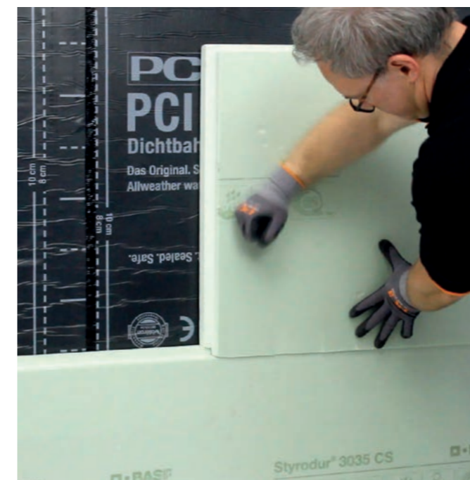
PCI Pecimor® DK zur Verklebung von Dämmplatten auf Bitumen-Dickbeschichtungen und KSK-Bahnen.
