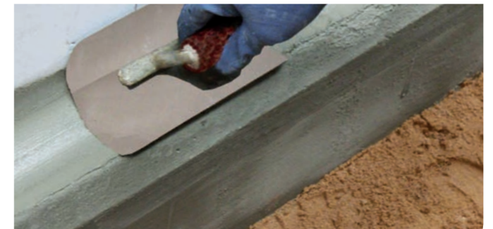
Erstellen einer wasserdichten Dichtungs-/Hohlkehle mit PCI Polyfix® plus L
