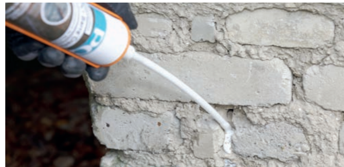
Injektion einer wasserabweisenden Horizontalsperre mit PCI Barra® Creme
