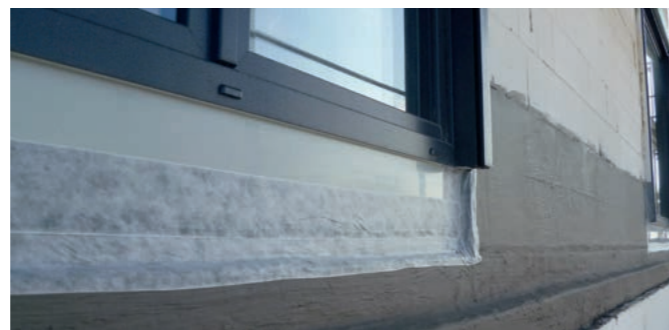
Anschluss Fensterelement mit Fixband PCI BT 42
