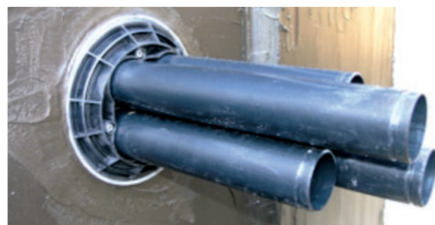
Anarbeiten von PCI Barraseal® Turbo an eine Mehrspartenhaufeinführung
