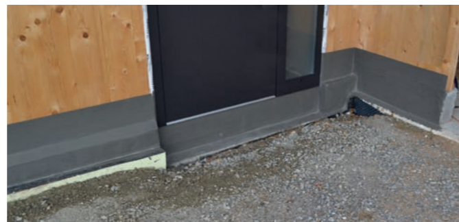
Anarbeiten der flexiblen mineralischen Dichtschlämme PCI Barraseal® Turbo an das Dichtband und Fensterelement
