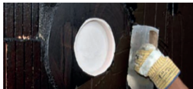
Anarbeiten von PCI Pecimor® 2K an einen Klebeflansch
