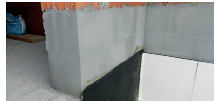
Zwischenabdichtung mit PCI Barraseal®
