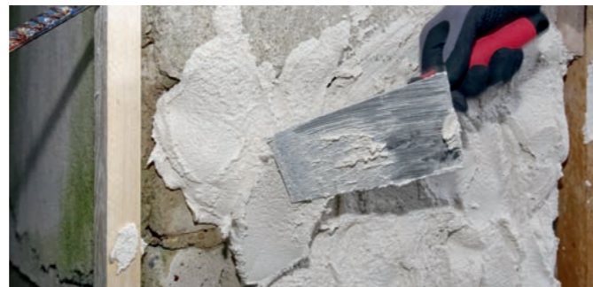
Aufbringen von PCI Saniment® 2 in 1 als Sanierputz und Feinputz in einem
