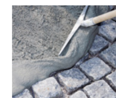
Einbringen des zementären Pflasterfugenmörtels PCI Pavifix CEM auf eine vorgemastete Pflastersteinfläche
