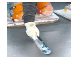
Estriche oberflächlich mit einer Traufel glätten
