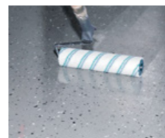
Eingestreute Farbchips mit PCI Pursol transparent versiegeln. Bei Beschichtungen ohne Farbchips kann die 2. Lage mit PCI Pursol 1K farbig erfolgen
