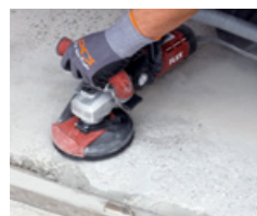
Alte Rückstände und Verunreinigungen durch Abschleifen entfernen
