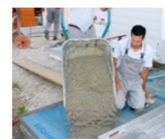
Einbau des Monokornmörtels PCI Pavifix DM auf eine unterstützende Drainmatte
