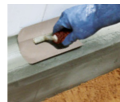
Ausbilden einer Dichtungs-/Hohlkehle am Übergang mit PCI Polyfix plus L
