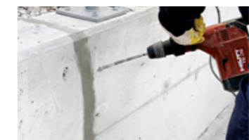
Bauteil schräg zum Rissverlauf abwechselnd rechts und links anbohren. Das Bohrloch muss den Riss etwa in der Mitte überschneiden
