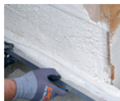
PCI Saniment 2 in 1 ist schnell nachbearbeitbar mit feinem Filzbild
