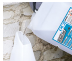
Mauerwerk mit der flüssigen Horizontalabdichtung PCI Barra Gisol gegen aufsteigende Feuchtigkeit schützen
