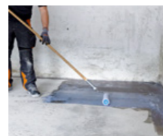
Zweimaliges Grundieren mit PCI Gisogrund 404 (im Kreuzgang sorgt für eine sichere Haftung des Bodenausgleichs auf dem Untergrund)
