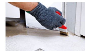
Händischer Auftrag der mattierenden Kopfversiegelung PCI Finopur
