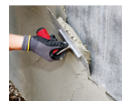
Aufbringen des faserverstärkten Feinspachtels PCI Nanocret FC
