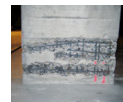
Freilegen eines mit Chlorid geschädigten Betons in einer Tiefgarage
