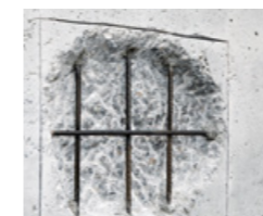
Die Bewehrungsstäbe von Rost und Altanstrichen befreien
