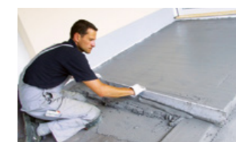
Mit Zusatzmitteln wie PCI Estrifix und PCI Dichtungsmörtel werden Verarbeitung und Eigenschaften von zementären Estrichen optimiert
