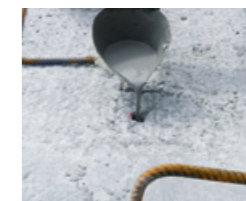
Verankern von Einbauteilen mithilfe von zementären Mörteln wie z. B. PCI Repafix
