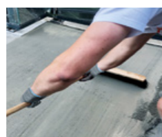
Ausführung eines Besenstrichs auf PCI Peciment 50
