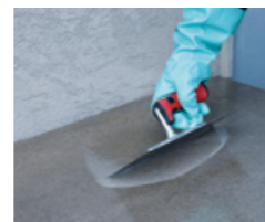
Eine porenfreie Kratzspachtelung ermöglicht eine sichere Haftung und blasenfreie Aushärtung der nachfolgenden Beschichtung
