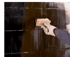
Grundierung je nach Witterung mit PCI BT 26 oder PCI BT 28
