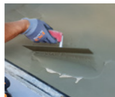
Und mit einer Rakel in der gewünschten Schichtdicke verteilt
