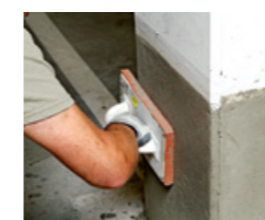
Schließen von Lunkern mit dem Feinspachtel PCI Nanocret FC
