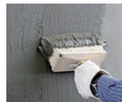
Aufbringen der mineralischen, sulfatbeständigen Abdichtung PCI Barraseal
