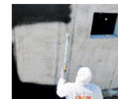
Ausbilden einer Dichtungs-/Hohlkehle am Übergang mit PCI Polyfix plus L
