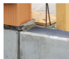
PCI Barraseal Turbo als Horizontalsperre unter Wänden
