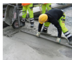
Standfester Ausgleich einer Bodenfläche aus Beton mit PCI Repafast Tixo
