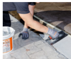
Aufbringen von PCI Aposan zum Überbrücken von Höhenunterschieden bis 50 mm
