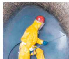
Vorbereiten einer geschädigten Betonoberfläche in einem Kanal
