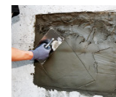
Den hochfesten Reparaturmörtel, z. B. PCI Nanocret R4 PCC, satt und hohlraumfrei händisch oder maschinell auftragen
