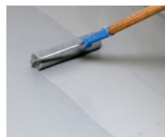
Nach zweimaligem Streichen mit PCI Supracolor ist die optische Sanierung abgeschlossen
