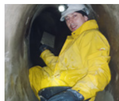
Aufbringen der sulfatbeständigen Dichtschlämme PCI Barraseal im Bereich von Abwässern
