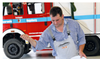
Einstreuen von Farbchips in die noch frische Beschichtung
