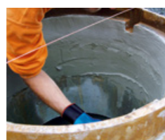
Auskleiden eines Schachtrings und Setzen mit PCI Polyfix plus L
