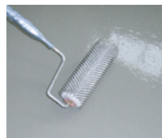
Das Material gleichmäßig verteilen und mit einer Stachelwalze entlüften
