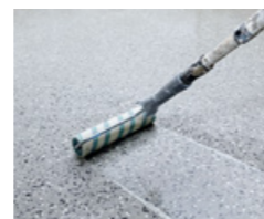
Optional PCI Farbchips einstreuen und dekorativ gestaltete Fläche mit PCI Finopur lichtecht und seidenmatt versiegeln
