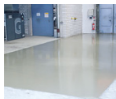
Ausgleich eines Betonbodens mit leicht verlaufendem Fließestrich PCI Zemtec 180
