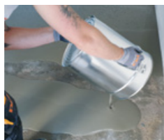
Die Bodenausgleichsmasse wird in Feldern auf den Boden aufgebracht
