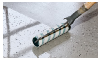
Aufbringen einer UV-stabilen Kopfversiegelung, z. B. PCI Finopur
