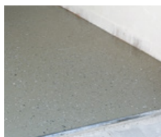
Während des Einbaus egalisiert und entlüftet sich PCI Zemtec Outdoor selbstständig
