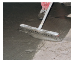
Aufbringen einer Mörtelhaftbrücke mit PCI Pecihaft
