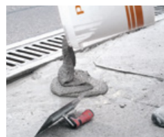
Fließfähiger Ausgleich einer Bodenfläche aus Beton mit PCI Repafast Fluid
