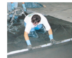
Estriche auf Dämm- und Trennlagen sind in homogenen Schichtdicken aufzubringen
