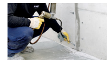
Das Injektionsharz von unten nach oben bis zur vollständigen Sättigung injizieren
