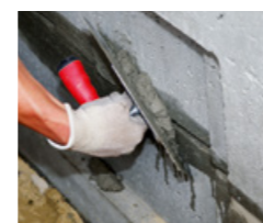
Schließen von Fugen und Angarnieren von Ecken und Kanten mit PCI Nanocret R2
