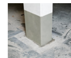
Mit dem Feinspachtel PCI Nanocret FC überarbeitete Stütze
