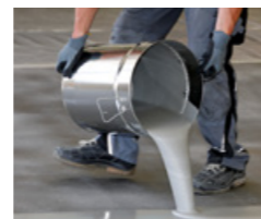
Aufbringen der Verlaufsbeschichtung
