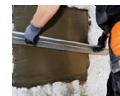
Den hochfesten Reparaturmörtel, z. B. PCI Nanocret R4 PCC, satt und hohlraumfrei händisch oder maschinell auftragen
