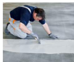
Händisches Anarbeiten an eine Dehnfuge
