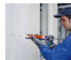
Verfüllen von Verankerungen mit Methacrylat PCI Barrafix 920
