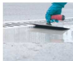
Anarbeiten an eine Rinne mit dem Epoxi-Vergussmörtel PCI Repaflow EP Plus
