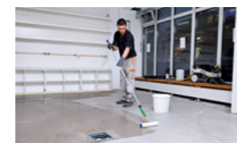
Nach ca. 1 Tag können die zementären Bodenausgleichsmassen mit einer Kopfversiegelung, z.B. PCI Zemtec Top, versiegelt werden
