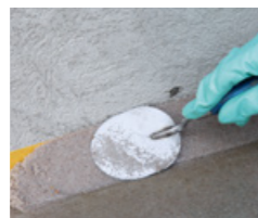
Erstellen einer Hohlkehle aus PCI Bauharz abgemischt mit Quarzsand
