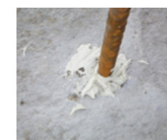
Fixieren von Verankerungen mit Methacrylat PCI Barrafix 920
