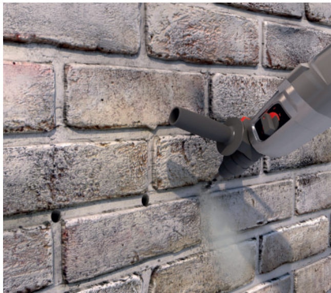
1. Bohren und anschließend Bohrloch ausblasen
