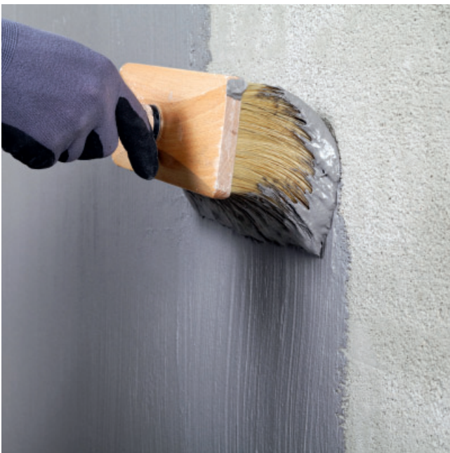
Sockelabdichtung im Außenbereich mit Streich und Spachtelfähigem PCI Barraseal® Turbo
