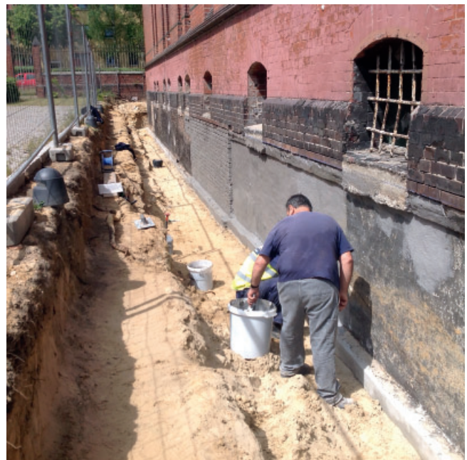
Nach der Injektion von PCI Barra® Creme über die Außenwand wird mit PCI Barraseal® Turbo über die Geländeoberkante hinaus abgedichtet.
