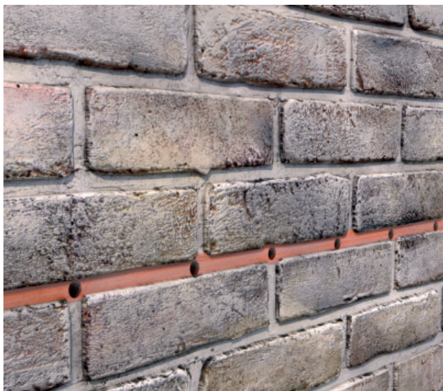
3. Ausgebildete Horizontalsperre aus PCI Barra® Creme
