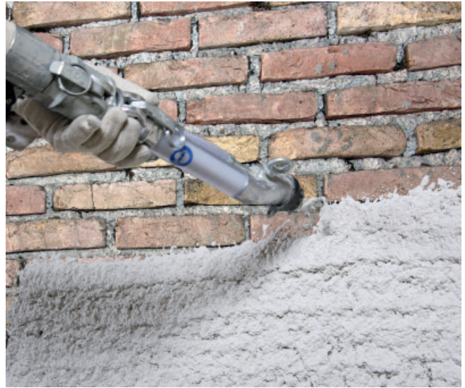
Einlagiger Auftrag des PCI Saniment® 2 in 1 auf eine Kellerinnenwand
