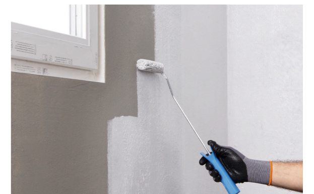
PCI Lastogum wird 2-lagig durch Rollen, Streichen oder Spachteln auf den Untergrund aufgebracht.
