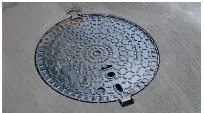
Einbetten eines Schachtrahmens mit PCI Repafast® Tixo bis -10 °C
