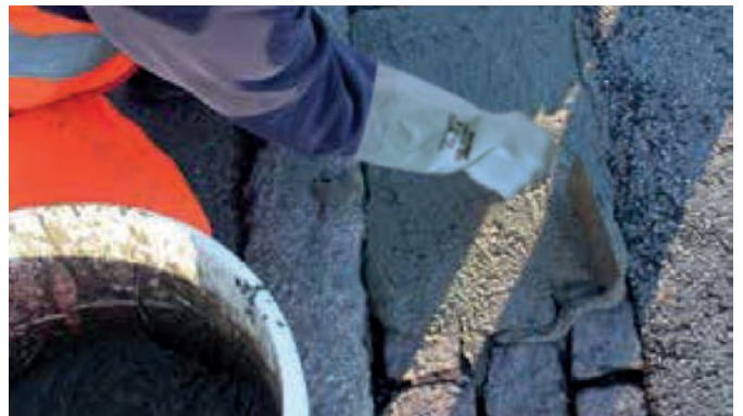
Verfugung von Pflastersteinen mit PCI Repafast® Fluid bis -10 °C
