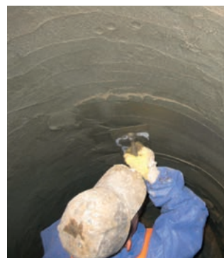
Partielle, manuelle Ausbesserung
