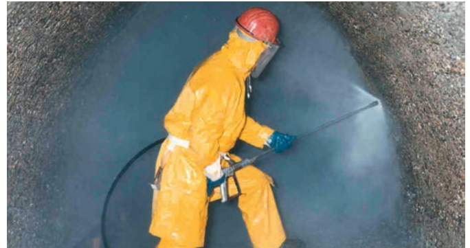
Vorbereiten der geschädigten Fläche mit Höchstdruckwasserstrahlen
