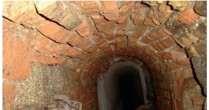
Klinkerflächen mit Hochdruckwasserstrahlen gereinigt
