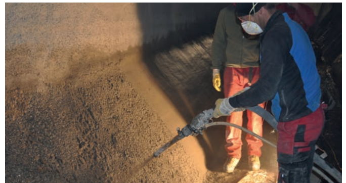
Vollflächige maschinelle Reprofilierung mit PCI Nanocret® R4 PCC
