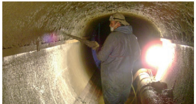
Vollflächiger Spritzauftrag von PCI Nanocret® R4 PCC
