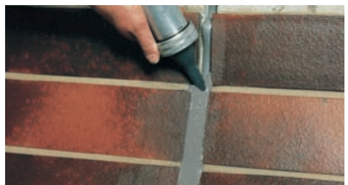
Fugensanierung bei Anschluss- und Bewegungsfugen
