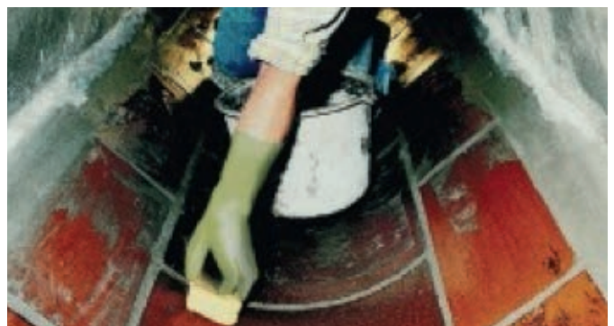
Fugenfüllung mit PCI Polyfix® plus L
