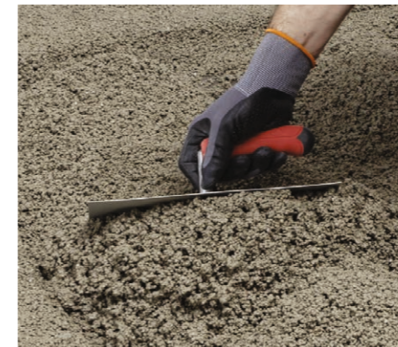
Ausbringen der Bettungsschicht
