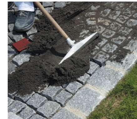
Einkehren des drainfähigen Fugenmörtels
