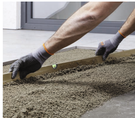
Abziehen des aufgetragenen Drainmörtels
