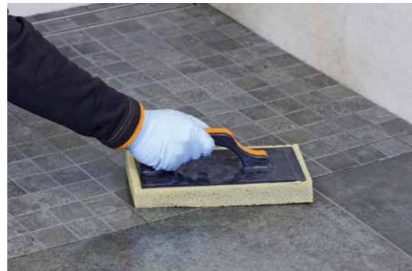
Einfaches Verfugen und Waschen mit einer Hand, ohne Epoxidharz-Spezialwerkzeug.
