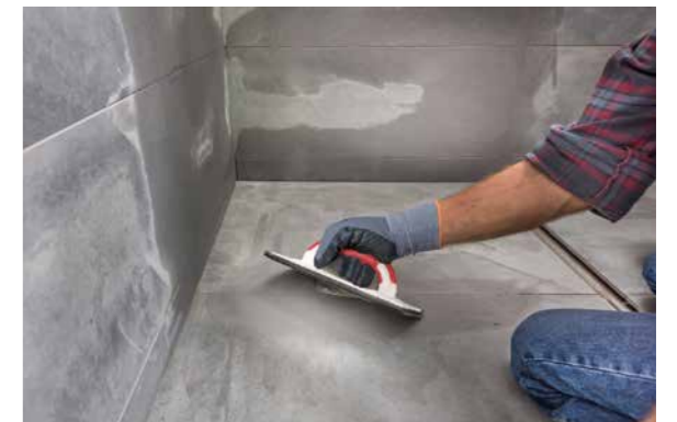
Geschmeidiges, leichtes Einfügen mit PCI Nanofug.
