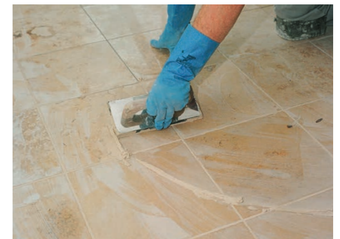
Verfugen mit schnell abbindendem Fugenmörtel
