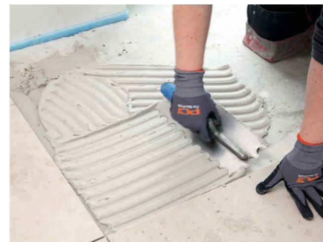
Verlegen Naturwerksteinbeläge auf Abdichtung
