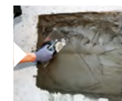
Kontaktschicht mit der ersten Lage Reparaturmörtel aufstreichen oder mit der Traufel aufkratzen
