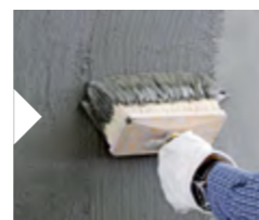
Aufbringen der mineralischen, sulfatbeständigen Abdichtung PCI Barraseal
