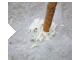
Fixieren von Verankerungen mit Methacrylat PCI Barrafix 920
