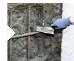
Kontaktschicht mit der ersten Lage Reparaturmörtel aufstreichen oder mit der Traufel aufkratzen
