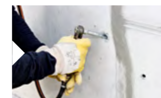
Den selbstdichtenden Packer in das zuvor gereinigte Bohrloch fest eindrehen
