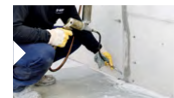
Das Injektionsharz von unten nach oben bis zur vollständigen Sättigung injizieren
