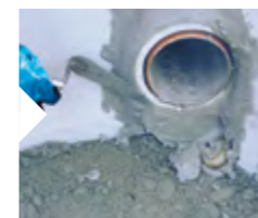
Setzen von Muffen mithilfe von zementären Mörteln wie z. B. PCI Repafix
