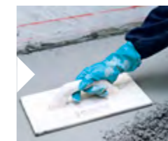
Bei Verbundestrichen ist eine Haftbrücke aus PCI Repahaft aufzubringen
