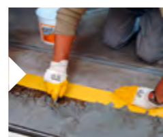
Ausgleich einer Schwelle oder Treppe mit standfestem Epoxi-Mörtel PCI Aposan
