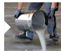
Aufbringen der Verlaufsbeschichtung
