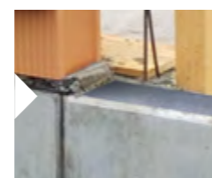
PCI Barraseal Turbo als Horizontalsperre unter Wänden
