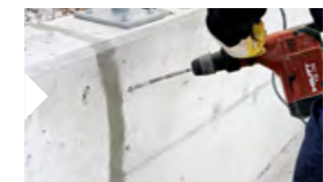
Risse und Klüfte sorgfältig mit Mörtel verschließen (ggf. zuvor aufweiten)
