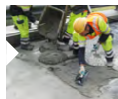
Standfester Bodenausgleich eines Betonausbruchs mit PCI Repafast Tixo
