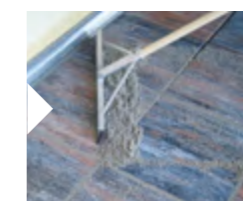
Einbringen des drainfähigen Pflasterfugenmörtels PCI Pavifix 1K Extra auf der vorgemasteten Natursteinfläche
