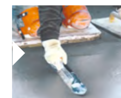
Estriche oberflächlich mit einer Traufel glätten
