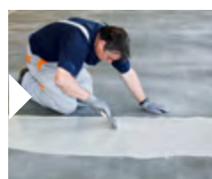
Händisches Anarbeiten an eine Dehnfuge
