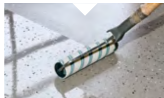
Aufbringen einer UV-stabilen Kopfversiegelung, z. B. PCI Finopur
