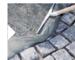
Einbringen des zementären Pflasterfugenmörtels PCI Pavifix CEM auf eine vorgemastete Pflastersteinfläche
