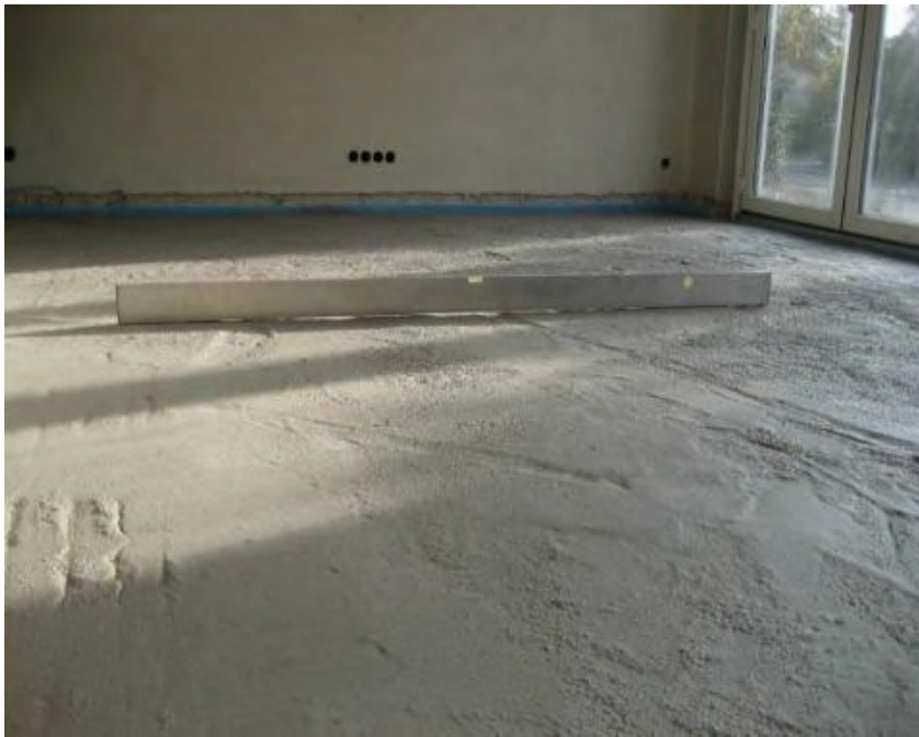
Wandausgleich mit spachtelbarem schnellen Mörtel
