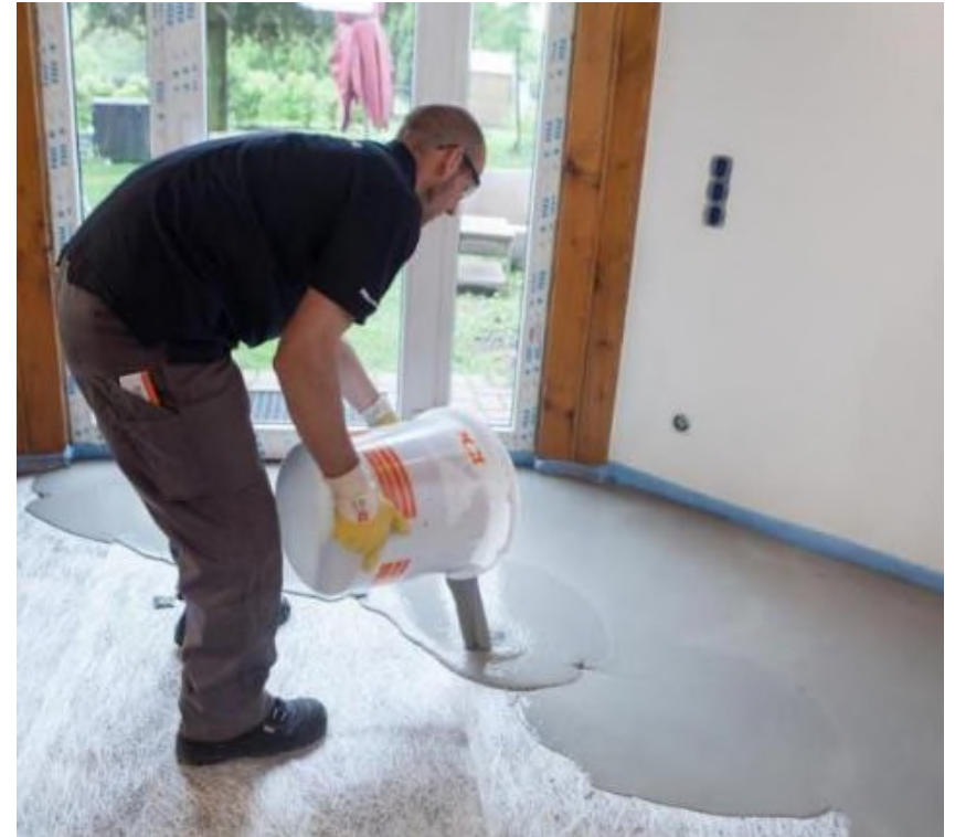
Bodenausgleich mit leichtverlaufender Ausgleichsmasse
