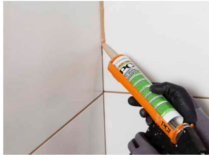
PCI Silcofug® E ist beständig gegenüber handelsüblichen Haushaltsreinigern und Desinfektionsmitteln; die geschlossene Fuge kann problemlos gereinigt werden.
