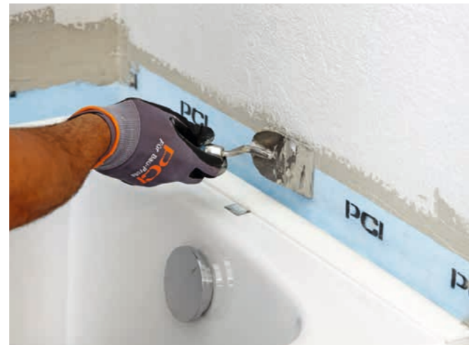
PCI Pecitape® WDB – einziges Wannendichtband mit allgemeinem bauaufsichtlichen Prüfzeugnis.
