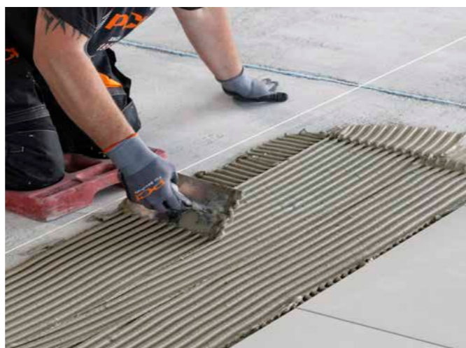
Für die Belegung von Zementestrichen/zementäre Heizestriche älter > 3 Tage (sobald begehbar).
