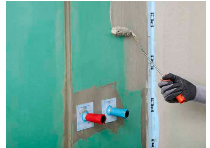
PCI Lastogum® wird unverdünnt durch Rollen, Streichen oder Spachteln auf den Untergrund aufgebracht.
