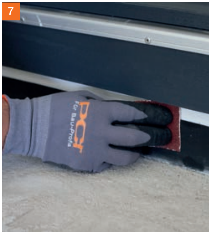
Detail Türabdichtung mit PCI Pectape® 120: Element anschleifen und anschließend reinigen mit PCI Univerdüner.
