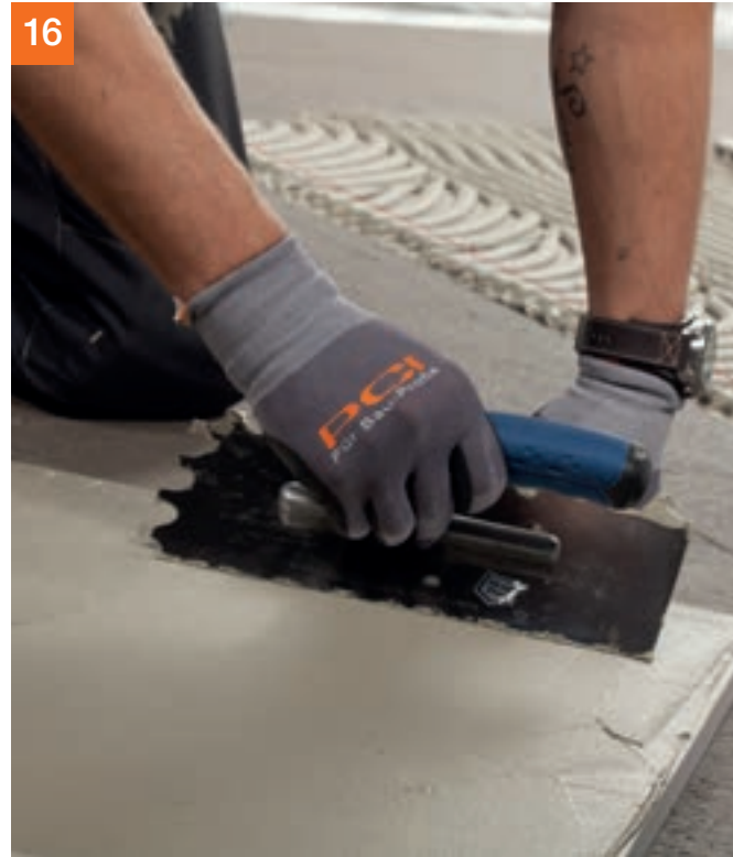
16 Kratzspachtelung mit PCI Flexmörtel® Premium auf der Fliesenrückseite aufziehen ...
