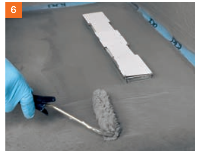
Anschließend die Entwässerungsrinne mit zwei Arbeitsgängen in die Flächenabdichtung einbinden.
