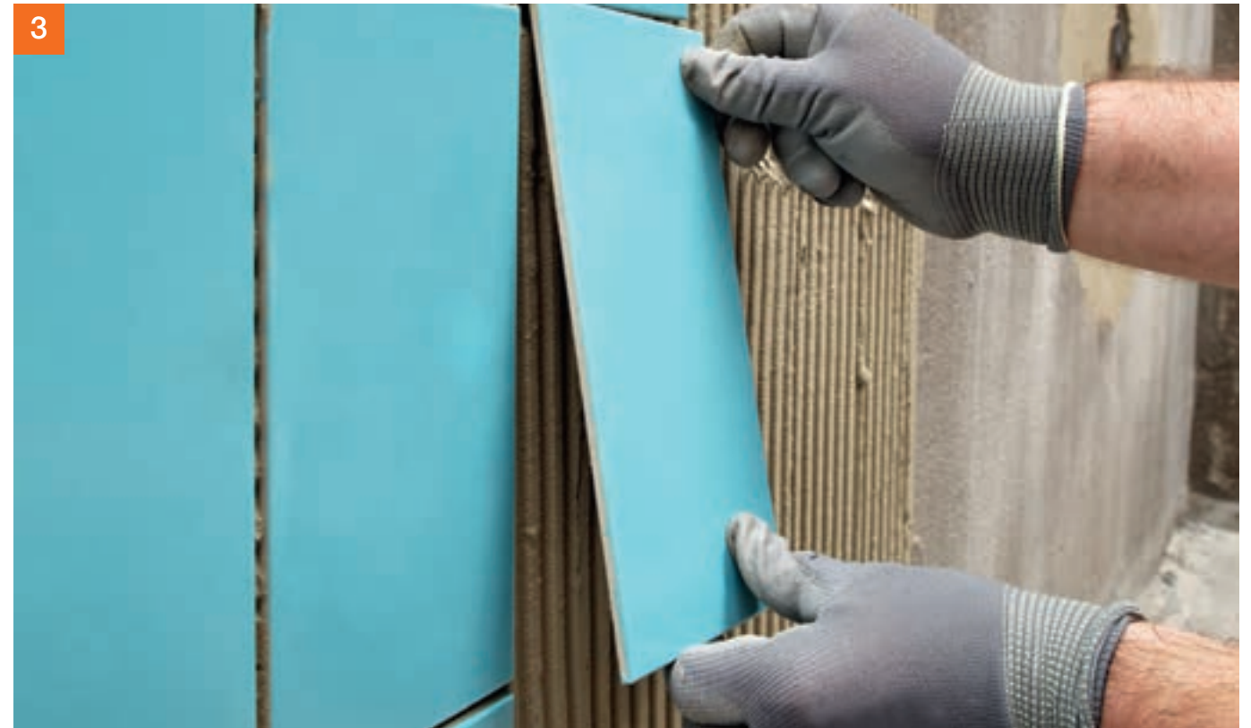
... und die Fliesen ansetzen und ausrichten. Buttering-Floating-Verfahren erforderlich.
