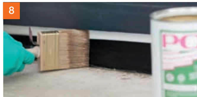
Element grundieren mit PCI Epoxigrund 390 ...
