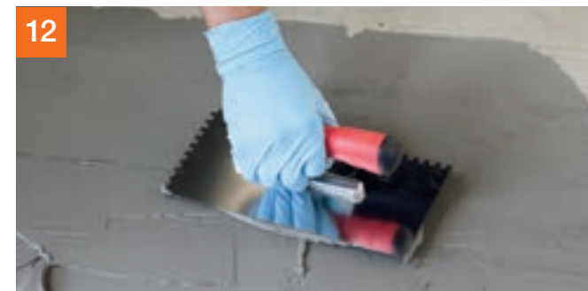
Kratzspachtelung mit PCI Seccoral® 2K Rapid ausführen.
