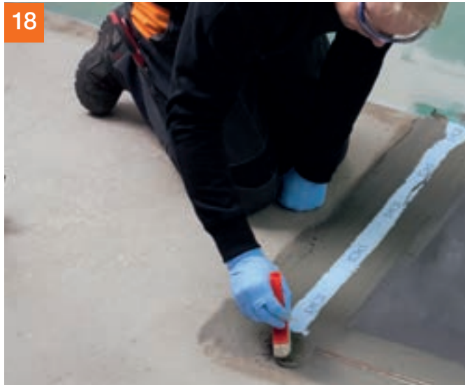
18 ... und noch einmal an den Randbereichen mit PCI Seccoral® 1K / 2K Rapid überstreichen.
