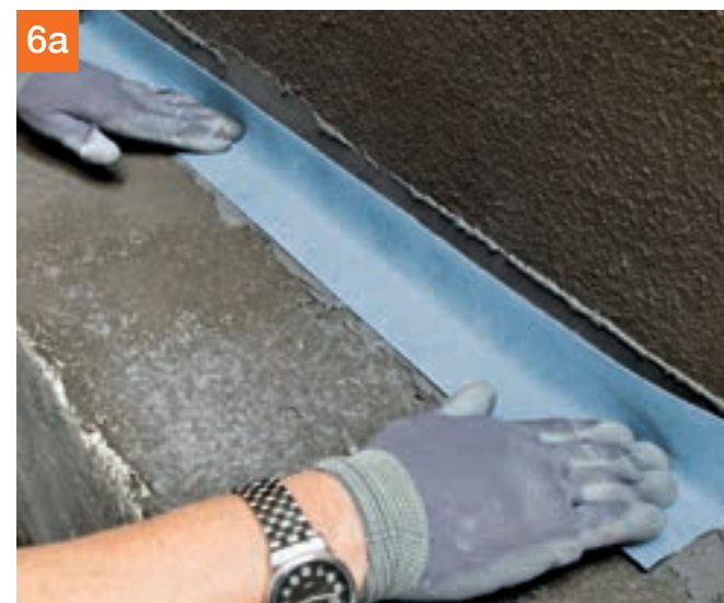
6a ... dann das Abdichtband PCI Pecitape® Objekt in die frische Dichtschlämme eingelegt und behutsam angedrückt. Die Ränder des Dichtbandes werden anschließend mit PCI Seccoral® 1K / 2K Rapid überarbeitet.
