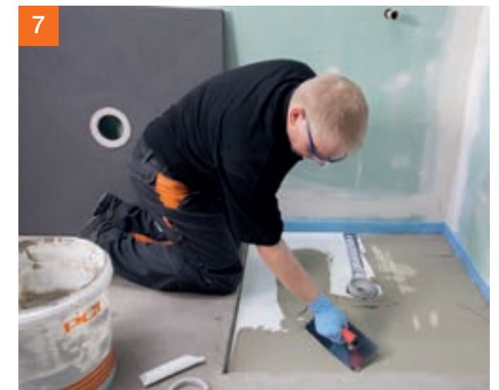
Fliesenkleber aufziehen, um das PCI Pecibord® mit dem Unterbauelement zu verkleben.
