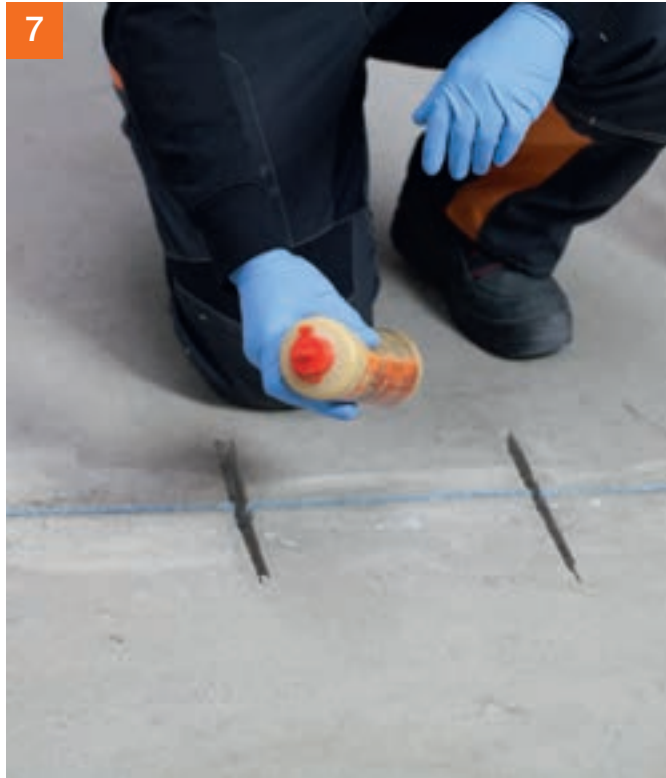
... und anschließend mindestens 20 Sekunden kräftig geschüttelt.
