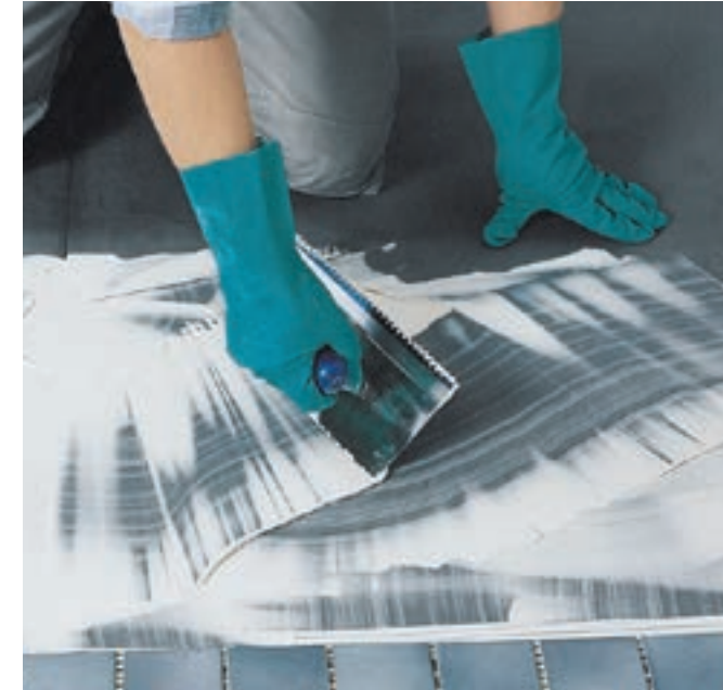
Mit dem verformungsfähigen Reaktionsharz-Fliesenkleber PCI Collastic® ...
