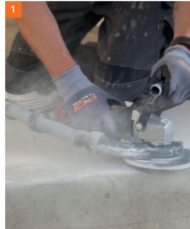
1 Untergrundvorbereitung: Grate entfernen.
