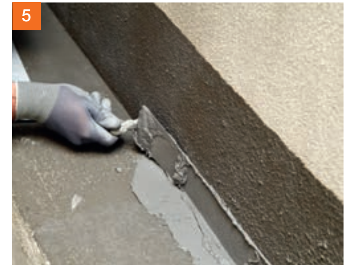
5 Zur Abdichtung von Kanten (zum Beispiel Wand-/Bodenanschlüssen) wird PCI Seccoral® 1K / 2K Rapid vorgelegt ...
