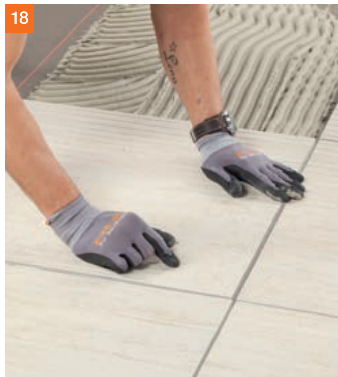
18 ... einschieben und ggf. mittels Gummihammer einklopfen. Danach ausrichten.
