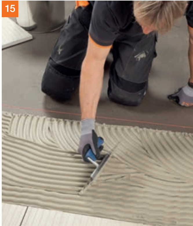
15 PCI Flexmörtel® Premium Kleberbett aufziehen.
