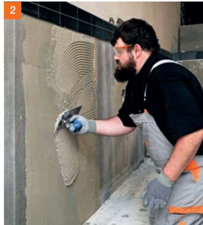
Anschließend den Kleber aufkämmen ...
