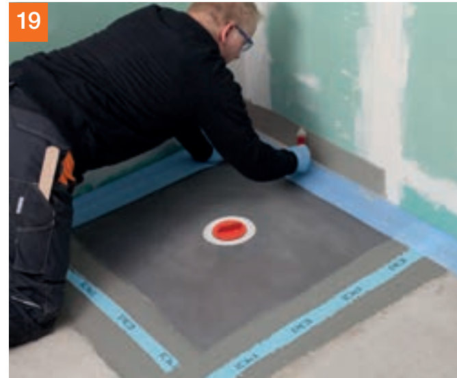
19 Nächster Schritt: Abdichten der Wand-/Bodenanschlüsse. Tipp: Zur Vermeidung von Schallbrücken vor der Applikation von PCI Seccoral® 1K / 2K Rapid an der Wand den Wand-/Bodenanschluss abdecken.
