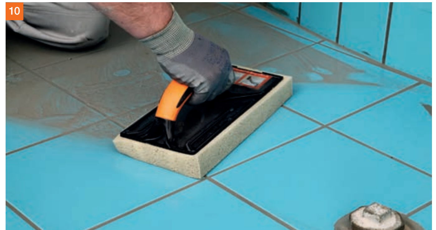
... und anschließend die Fläche nachwaschen und sauber abziehen.
