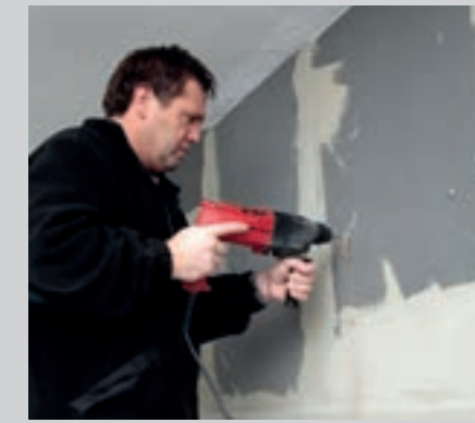
Nach Erhärtung des Klebemörtels werden die Bohrungen für die Dübel (ca. 5 Stck./m 2 ) gesetzt.
