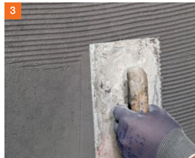
3 ... und streichen Sie anschließend die Stege gleichmäßig zu.
