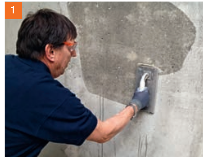
1 Das gründliche Vornässen reduziert die Saugfähigkeit des Betons und verhindert, dass der nachfolgenden Abdichtung zu schnell das Wasser entzogen wird.
