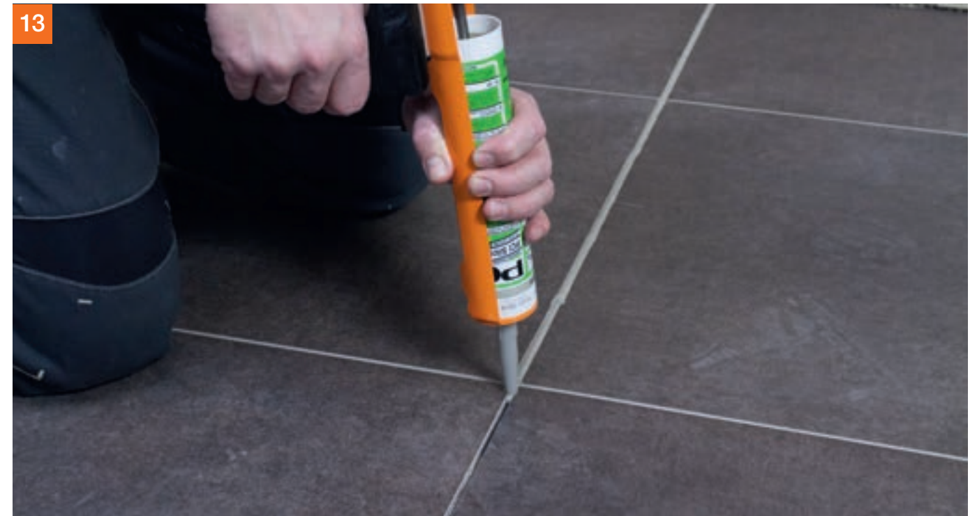
Nach dem Verfugen der Bodenfläche mit PCI Nanofug® Premium wird die an die Trennfuge angrenzende Belagsfuge mit PCI Silcofug® E versiegelt. Diese muss nicht breiter als die übrigen Belagsfugen ausgeführt werden und fügt sich so harmonisch in das Fugenbild ein.
