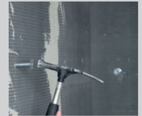
Zu guter Letzt die Schlagdübel einschlagen.
