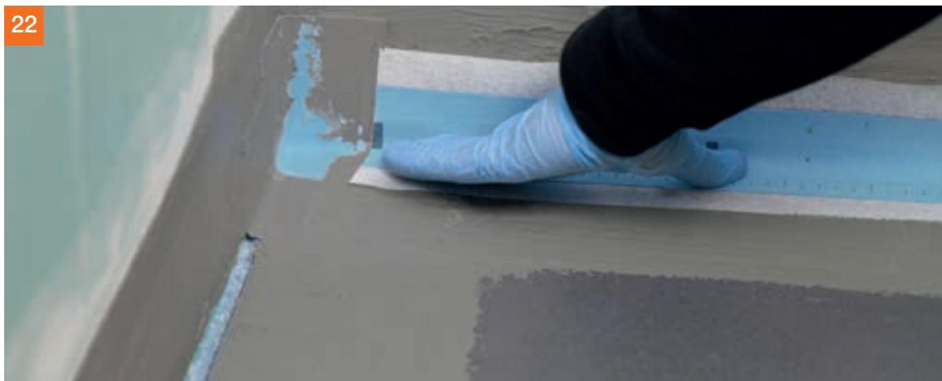
22 ... dann PCI Pecitape® 120 einlegen, andrücken ...
