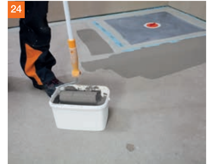
24 Anschließend Ausführen der Flächenabdichtung: 1. Auftrag mit PCI Seccoral® 1K / 2K Rapid.
