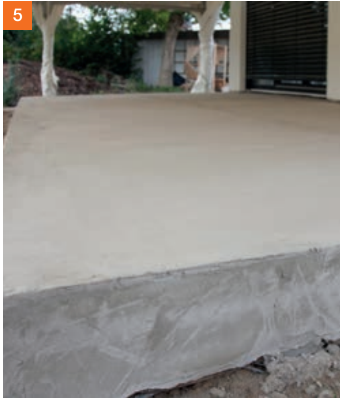
Terrassenplatte mit PCI Pericret® im Gefälle gespachtelt.
