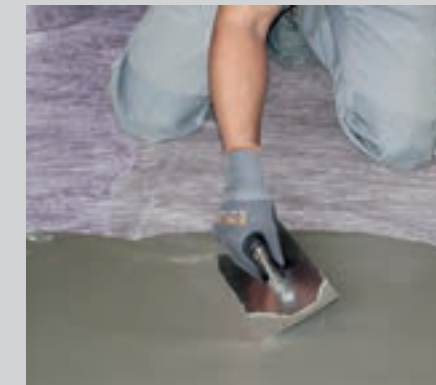
Mit einer Glättkelle verteilen (keine Rakel verwenden!) ...
