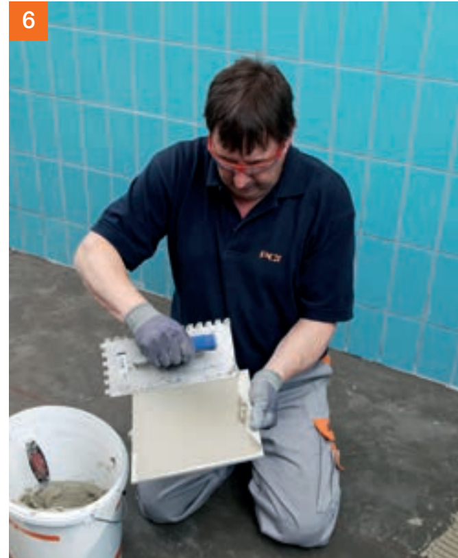
... wird das Buttering-Floating-Verfahren angewendet.
