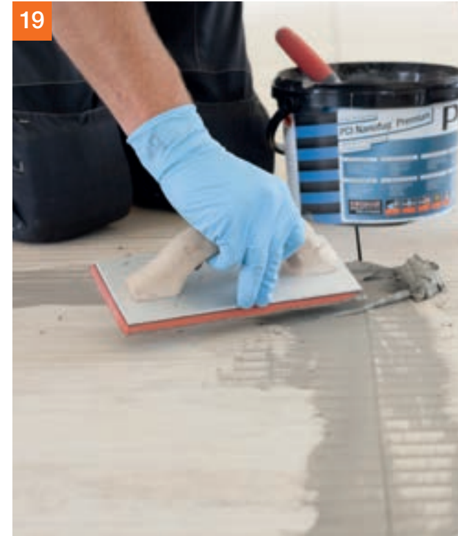
19 Fliesenbelag mit PCI Nanofug® Premium einfügen ...
