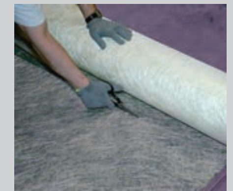
Das Glasfasergelege der PCI Armiermatte GFM mit einer Schere zurechtschneiden und auf dem grundierten Untergrund auslegen bzw. ausrollen.
