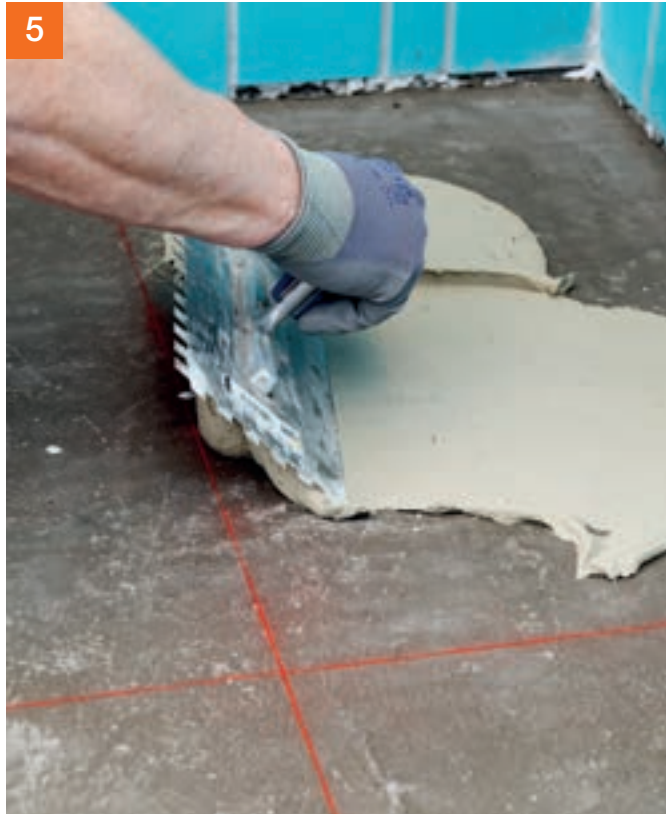
Auch bei der Verlegung der Bodenfliesen ...
