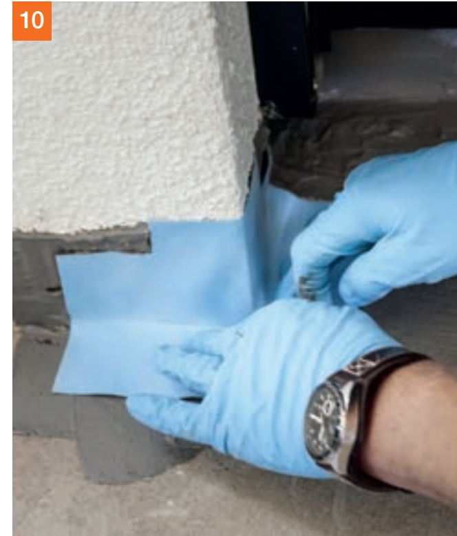
Detail Wandanschluss: PCI Seccoral® 2K Rapid vorlegen und Außenecke einlegen.
