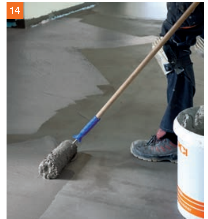
PCI Seccoral® 2K Rapid kann auch – bis zum Erreichen der erforderlichen Trockenschichtdicke von 2 mm – mittels Lammfellrolle aufgetragen werden.
