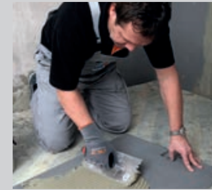
Den Klebemörtel mittels Zahntraufel auf der Plattenrückseite aufziehen. Bei größeren Unebenheiten kann in der „Batzenmethode“ gearbeitet werden.
