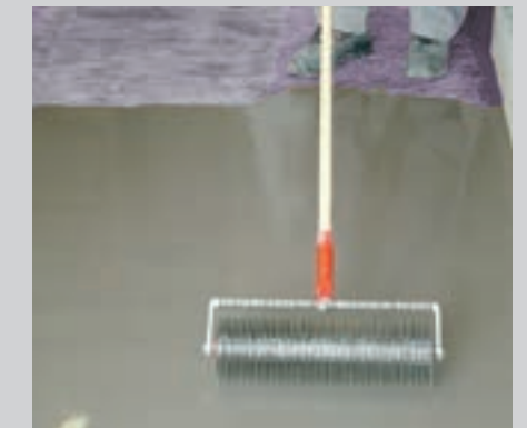
... und mit einer geeigneten Stachelwalze entlüften.
