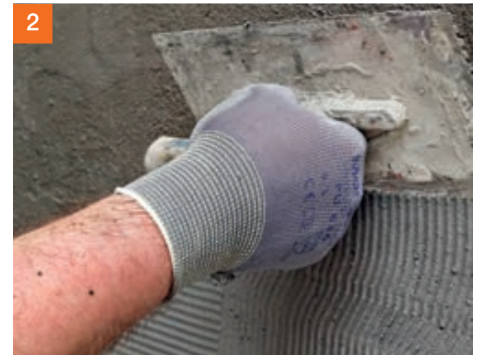
2 1. Auftrag PCI Seccoral® 1K / 2K Rapid. Ziehen Sie die Abdichtung mit einem Zahnpachtel (6 mm) auf ...
