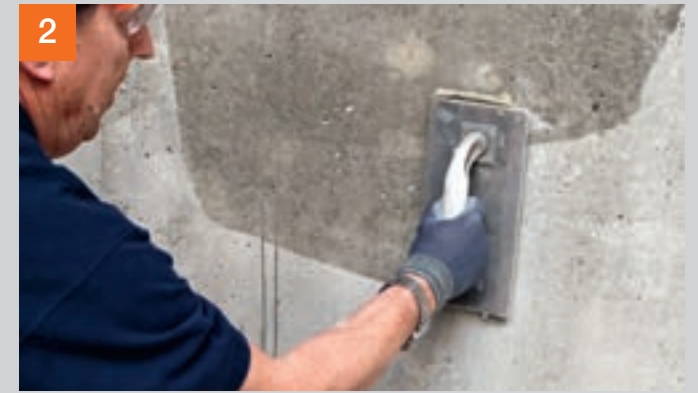
2 Zur Regulierung des Saugverhaltens den Untergrund leicht anfeuchten oder abhängig von der nachfolgenden Anwendung mit PCI Gisogrund® oder PCI Gisogrund® 404 grundieren.
