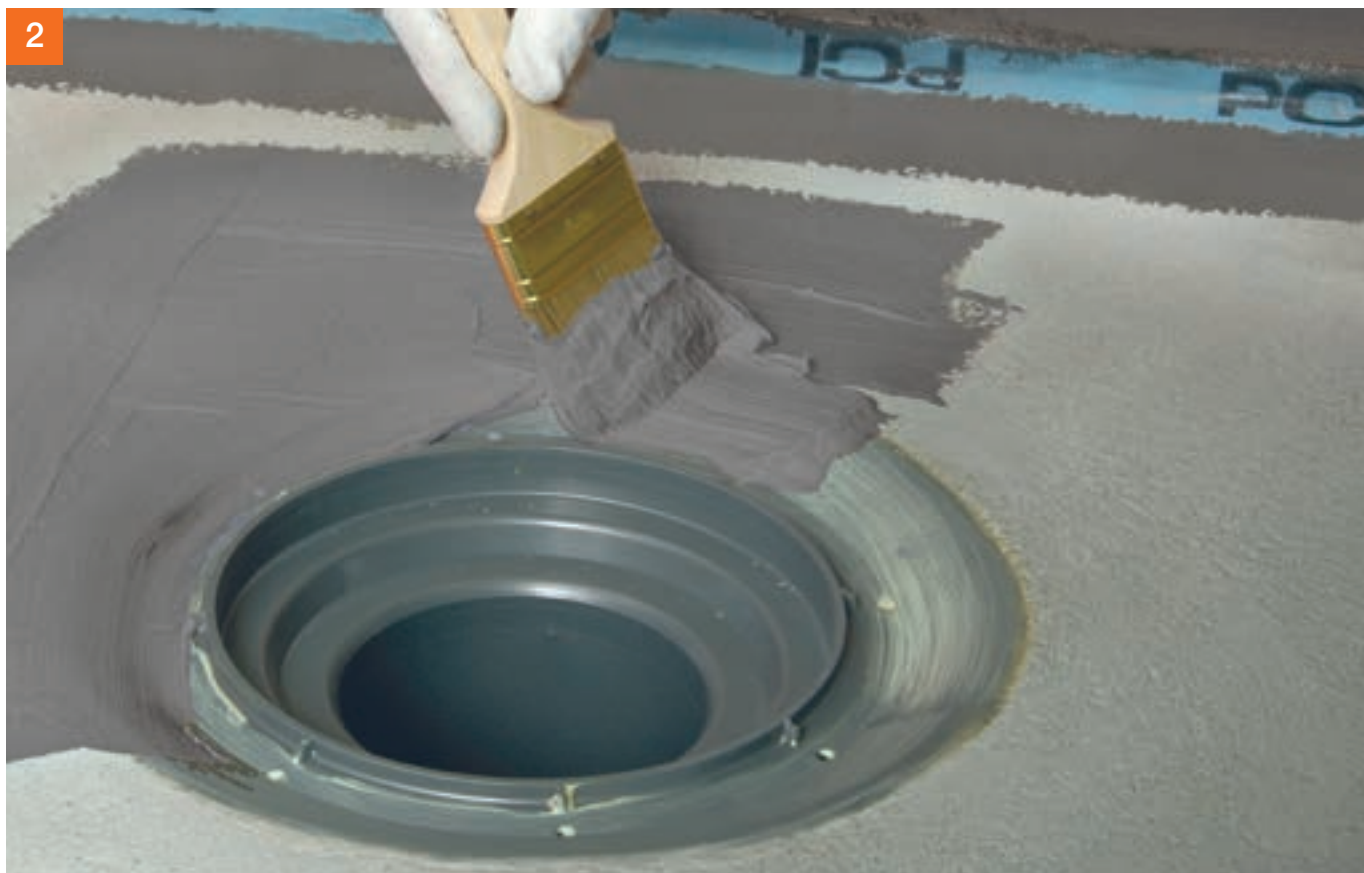
PCI Seccoral® 1K / 2K Rapid vorlegen ...
