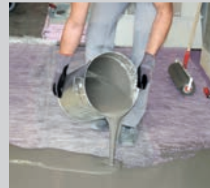
Die Bodenausgleichsmasse PCI Periplan® Extra in einer Mindestschichtdicke von 10 mm ausgießen.
