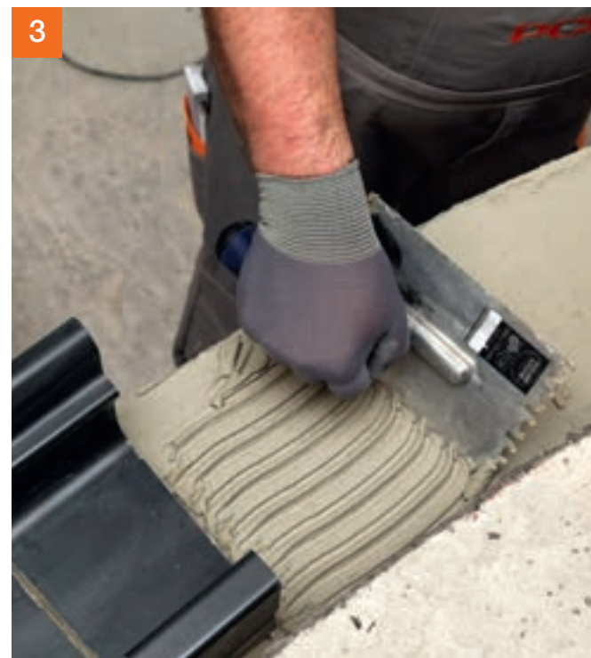
... und dann das Kleberbett aufkämmen.
