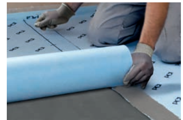
Die Stöße der Bahnen müssen ca. 5 bis 10 cm überlappen. Die Überlappung der Bahnen mit PCI Seccoral® 1K / 2K Rapid einstreichen und innerhalb der klebeoffenen Zeit die folgende Bahn eingelegt und sorgfältig angedrückt.
