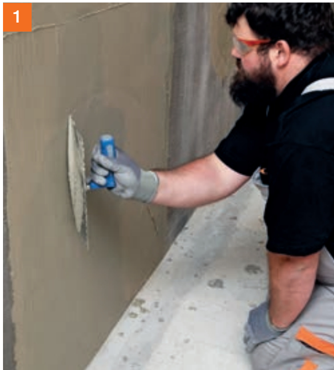
Kratzspachtelung mit PCI FT® Klebemörtel vergütet mit PCI Lastoflex® ausführen.
