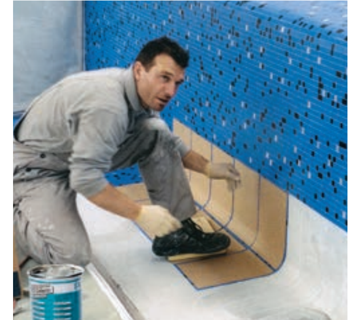
... werden keramische Beläge sicher auf Stahlkonstruktionen verlegt.
