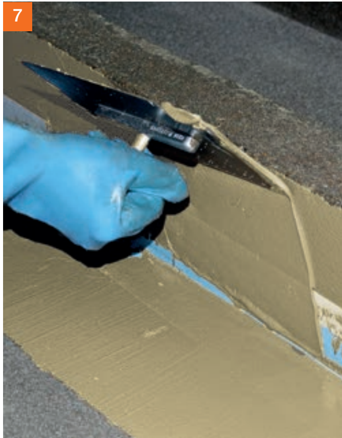
Anschließend noch einmal mit PCI Apoflex® überarbeiten.
