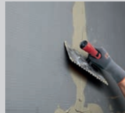
Die Plattenstöße und Anschlüsse werden mittels Klebemörtel beigespachtelt. Bei Bedarf kann auch zusätzlich ein Glasseidengewebe, zum Beispiel PCI Gewebbahn, eingespachtelt werden.
