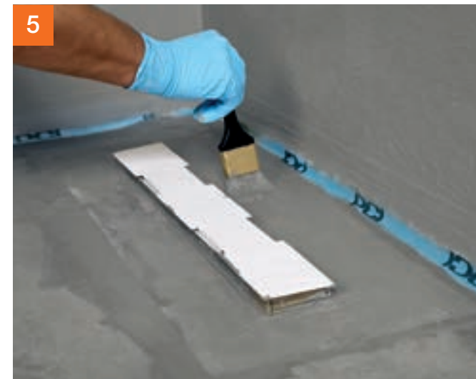
... und mit etwas Abdichtungsmaterial nochmals überstreichen.
