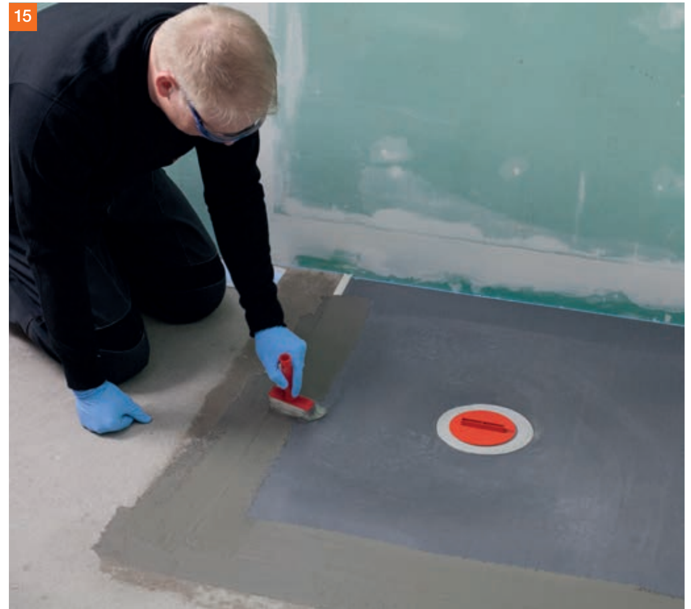
15 PCI Seccoral® 1K / 2K Rapid als Kleber für die Abdichtbänder vorlegen ...
