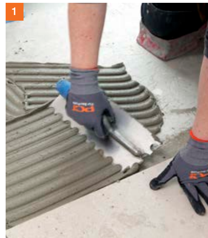
1 Aufziehen des Naturwerksteinklebers (z. B. PCI Carrament®) mit einer Mittelbettzahnung.
