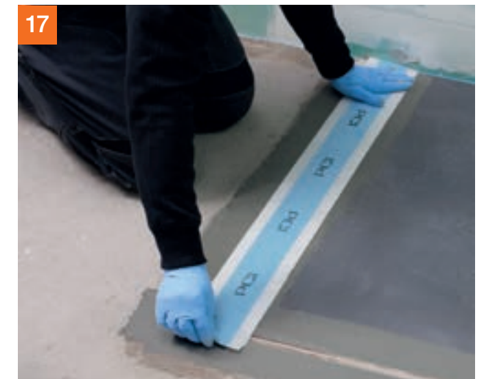
17 ... PCI Pecitape® 120 einlegen, andrücken ...
