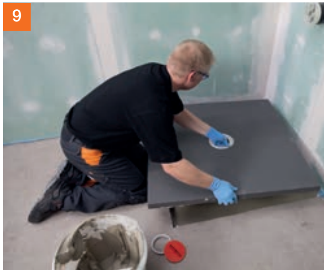
9 ... und das PCI Pecibord® ansetzen und andrücken, bis der Dichtungsring den Rand des Bodenablaufs sauber umschließt.
