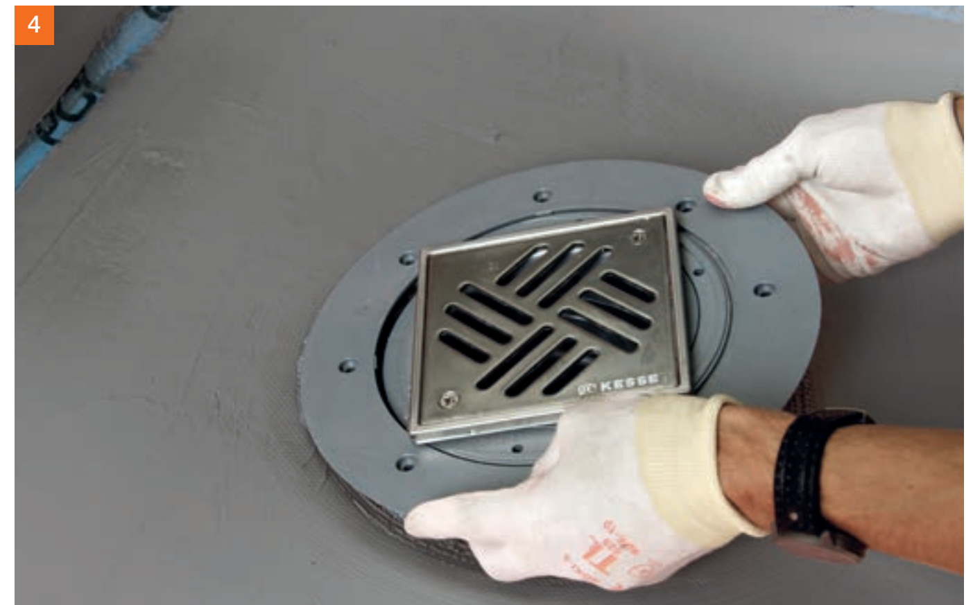
Klemmflansch aufsetzen und festschrauben.
