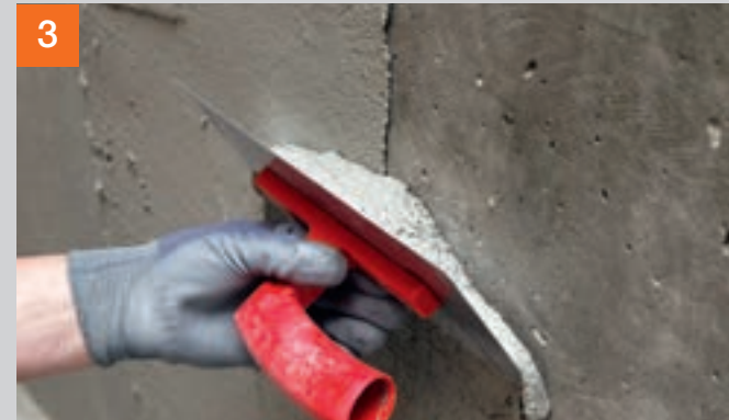
3 Fläche mit PCI Pericret® egalisieren.
