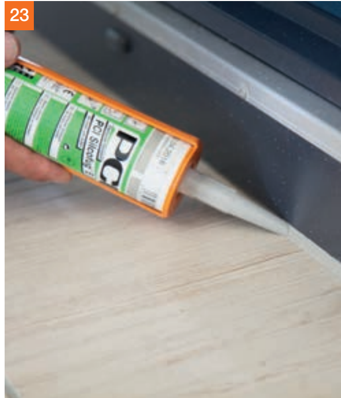
23 Silikonieren mit PCI Silcofug® E oder PCI Silcoform® S im Anschlussbereich zum Kunststofffenster.
