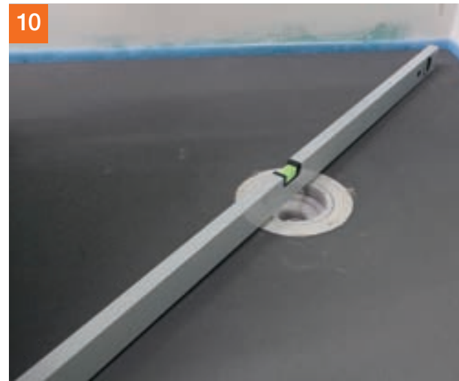
10 Korrekten Einbau mittels Wasserwaage prüfen und ...
