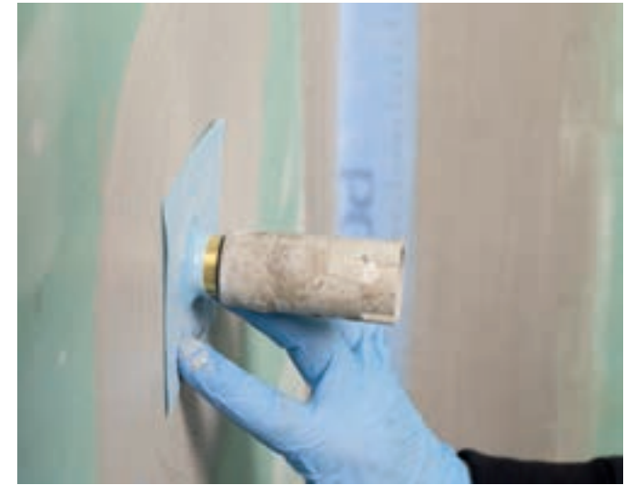
und Dichtmanschette PCI Pectape 10x10 in das frische Material einlegen.
