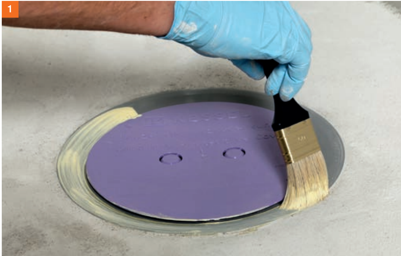
Grundierung des Flansches mit PCI Gisogrund® 303 oder PCI Gisogrund® 404.
