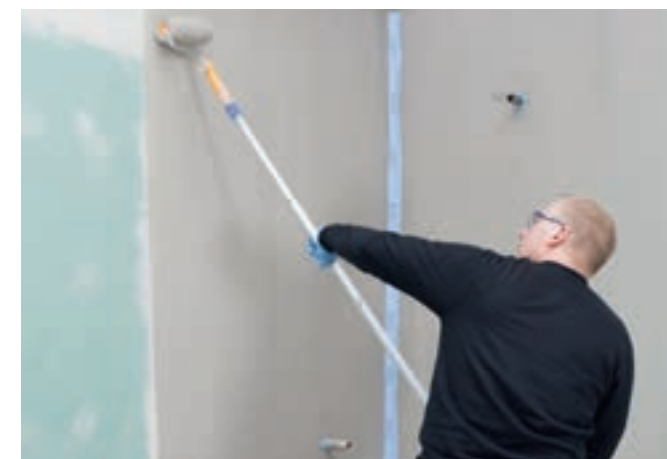
Flüssigabdichtungen sind immer mindestens 2-lagig auszuführen.
