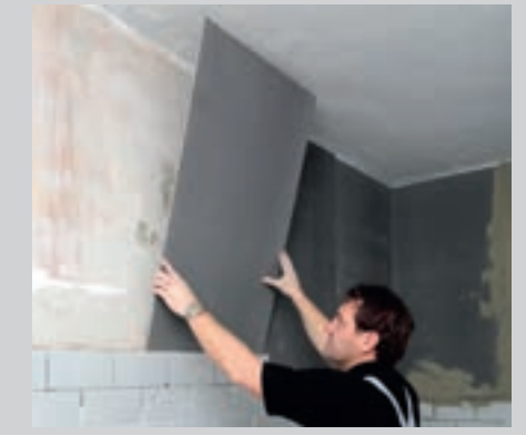
PCI PowerBoard-Element ansetzen und anschließend anklopfen.
