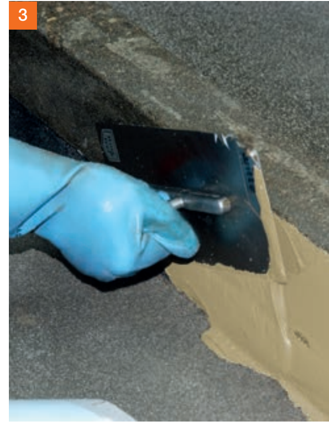
Vor dem Verkleben der Abdichtbänder wird PCI Apoflex® vorgelegt.
