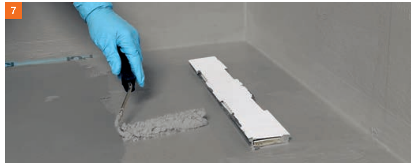
Nach einer Wartezeit von ca. 1 Stunde erfolgt jeweils nächste Auflag bis zum Erlangen der Mindestrockenschichtdicke von 2 mm.
