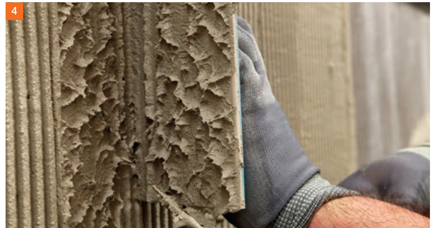
Das Ergebnis: eine fachgerechte, nahezu hohlraumfreie Verlegung der Fliese.
