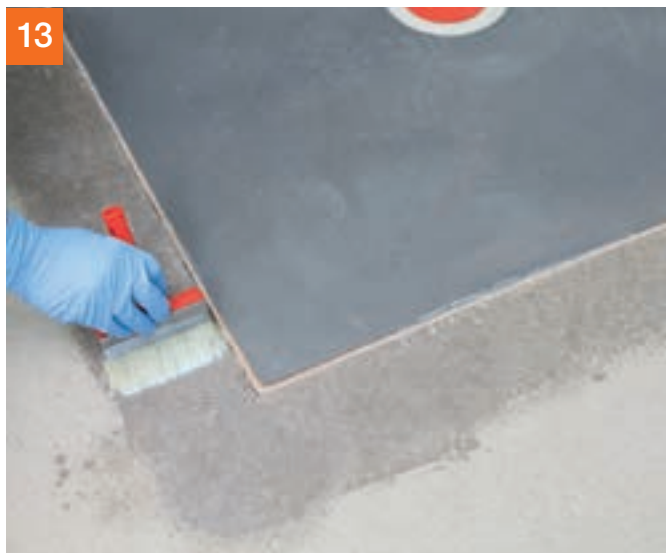
13 Estrich im Übergangsbereich mit Wasser vornässen.
