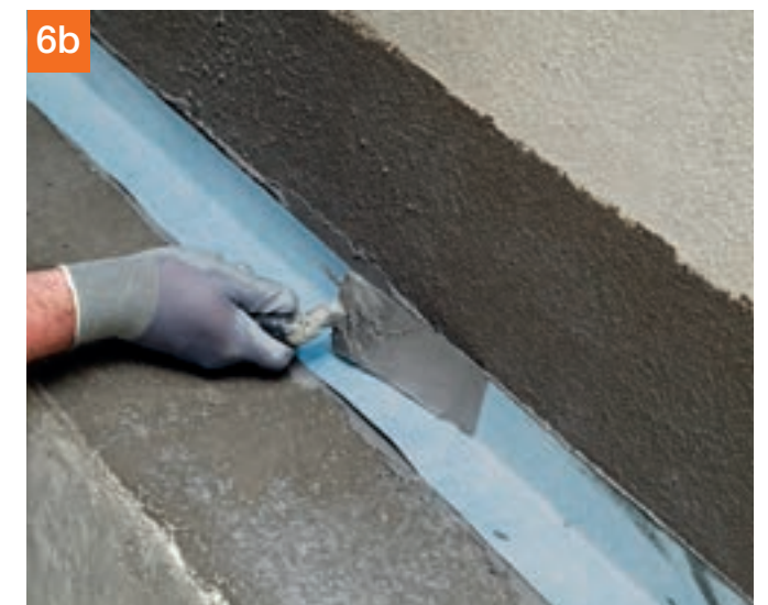
6a ... dann das Abdichtband PCI Pecitape® Objekt in die frische Dichtschlämme eingelegt und behutsam angedrückt. Die Ränder des Dichtbandes werden anschließend mit PCI Seccoral® 1K / 2K Rapid überarbeitet.
