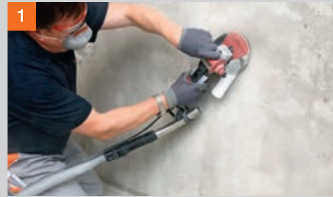
1 Grate und grobe Unebenheiten mittels Handfräse egalisieren.
