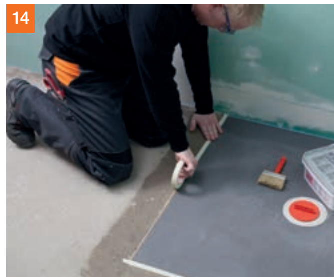
14 Tipp: Kleben Sie den schallentkoppelnden Randdämmstreifen mit einem Klebeband ab. Dann kann dort nichts dazwischenlaufen.
