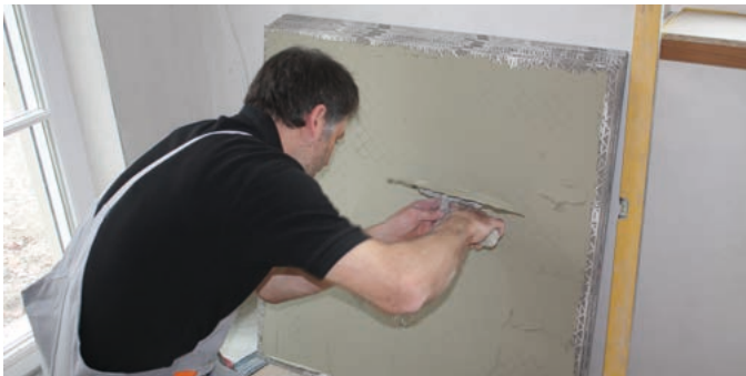
Abb. 11 – Das rückseitige Abspachteln verhindert Luft einschüsse und optimiert die Verbundhaftung.
