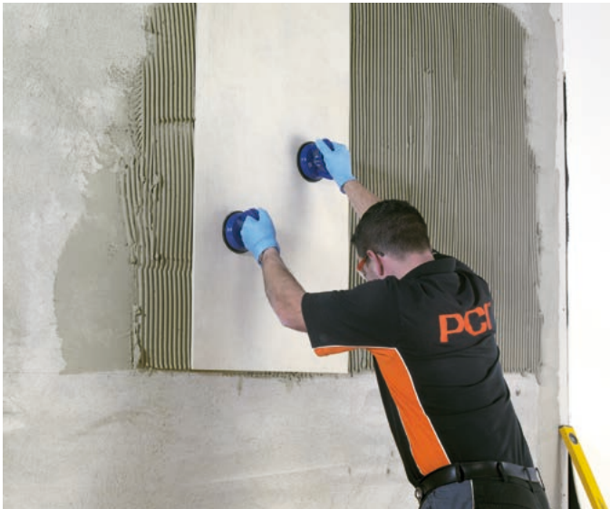
Abb. 2 – Großformatige Fliesen sind oft echte „Schwergewichte“... Mit dem hochstandfesten Dünnbettmörtel PCI Flexmörtel S1 kein Problem!
