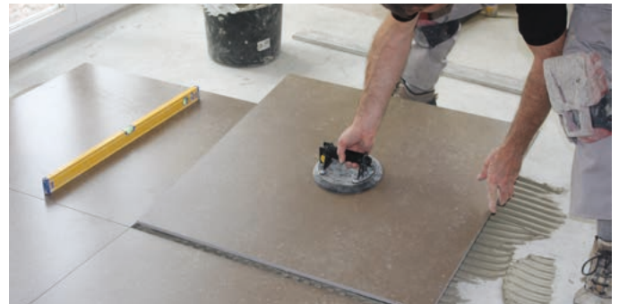
Abb. 12 – Verlegung einer Feinsteinzeugfliese im Format 90 x 90 cm. Hilfsmittel wie der hier verwendete Saugheber sind eine große Arbeitserleichterung.
