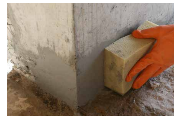
Der Feinspachtel PCI Barrafill L eignet sich insbesondere für vollflächige Kosmetikarbeiten an Betonbauteilen.
