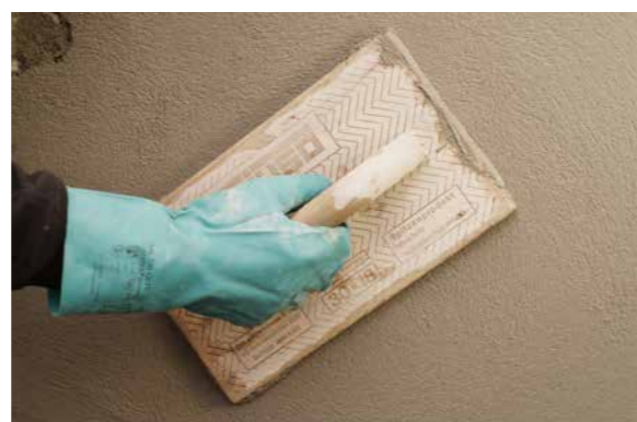
Schnelles Ausbessern von Ausbrüchen – nur eine der vielen Einsatzmöglichkeiten des universellen Reparaturmörtels PCI Nanocret R2.
