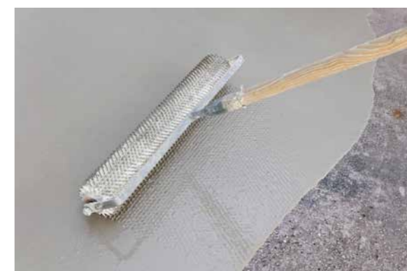
Der vollflächige Bodenausgleich PCI Zemtec 1K ist leicht verlaufend und direkt nutzbar.
