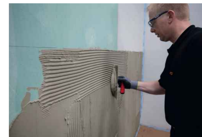
PCI Flexmörtel® S1 ist komfortabel beim Aufziehen und besonders standfest auch bei großformatigen Feinsteinzeugfliesen an der Wand.
