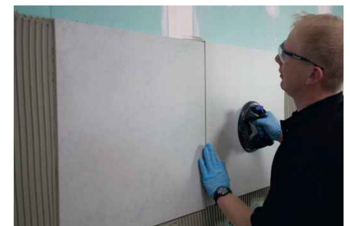
PCI Flexmörtel® S1 ist komfortabel beim Aufziehen und besonders standfest auch bei großformatigen Feinsteinzeugfliesen an der Wand.
