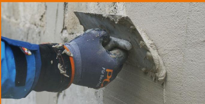
Mit seiner hohen Standfestigkeit und großen Schichtdickentoleranz können Flächen und Ausbrüche bequem und ohne Kraftaufwand ausgeglichen werden.
