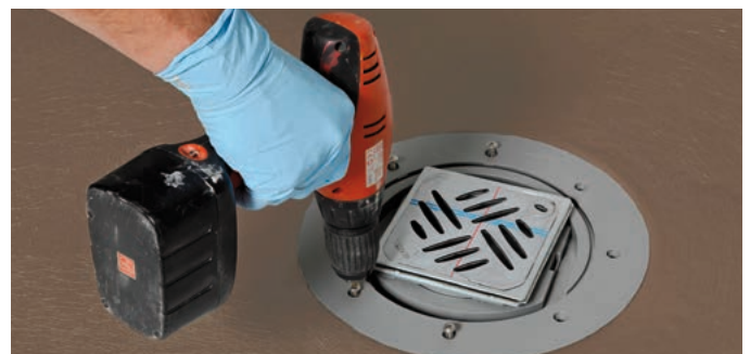
Abb. 13 – Klemmflansch aufsetzen und festschrauben.
