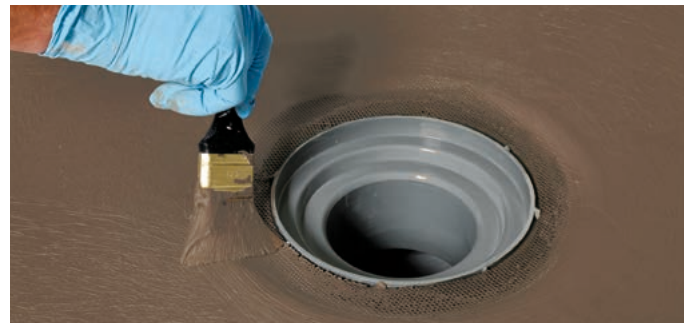
Abb. 12 – Gewebe (im Lieferumfang Fa. Kessel) in den frischen Auftrag einlegen, andrücken und deckend überstreichen.
