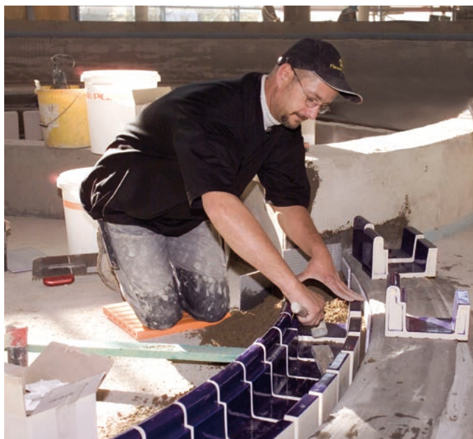
Abb. 10 – Verlegen der Rinne.
