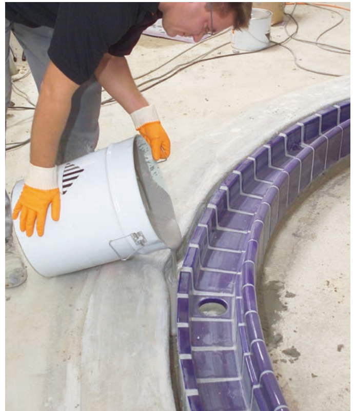
Abb. 3 – Einbringen des kapillarbrechenden Vergusses (PCI Apoten®, 1:1 mit PCI Quarzsand 0,3 – 0,8 mm verschnitten).
