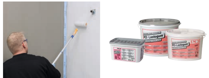
Abb. 14-15 – Kontrastfarbe weiß und grau zur sicheren Differenzierung auch nach der Trocknung
