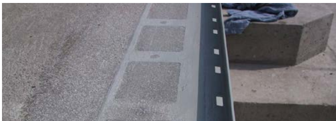
Abb. 2 – Oberflächenbündig eingebauter Abschlusswinkel mit Entwässerungsöffnungen
