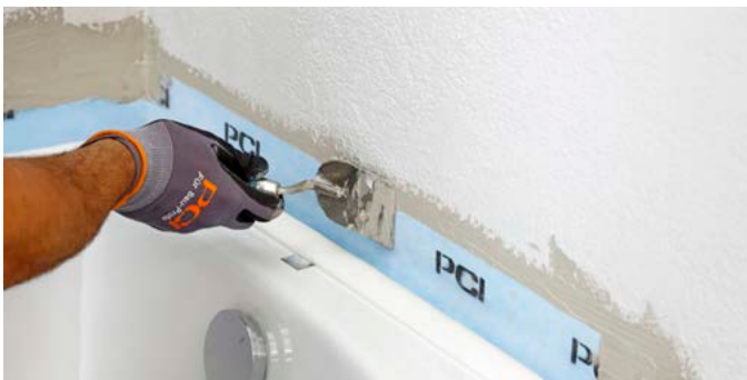
Abb. 23 – Einbau eines Wannendichtbandes
