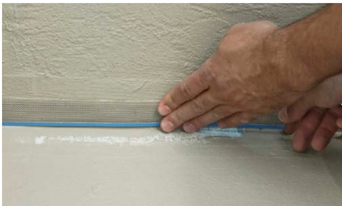
Abb. 18 – Zum Schutz des Dichtbandes kann ein Schnittschutzband verwendet werden
