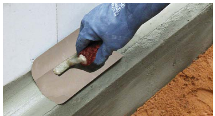
Abb. 7 – Einsatz von PCI Polyfix Plus L als Dichtungskehle
