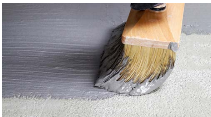
Abb. 6 – Auftrag von PCI Barraseal Turbo als Querschnittsabdichtung
