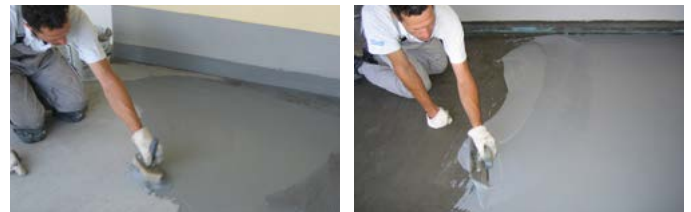
Abb. 4-5 – PCI Seccoral 1K/2K Rapid: Nach dem Grundieranstrich folgen der erste und weitere Aufträge in der Regel im Spachtelverfahren
