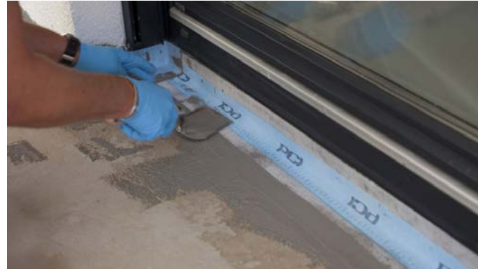
Abb. 3 – Einbetten von Dichtband und Dichtecken PCI Pecitape im Wandanschluss
