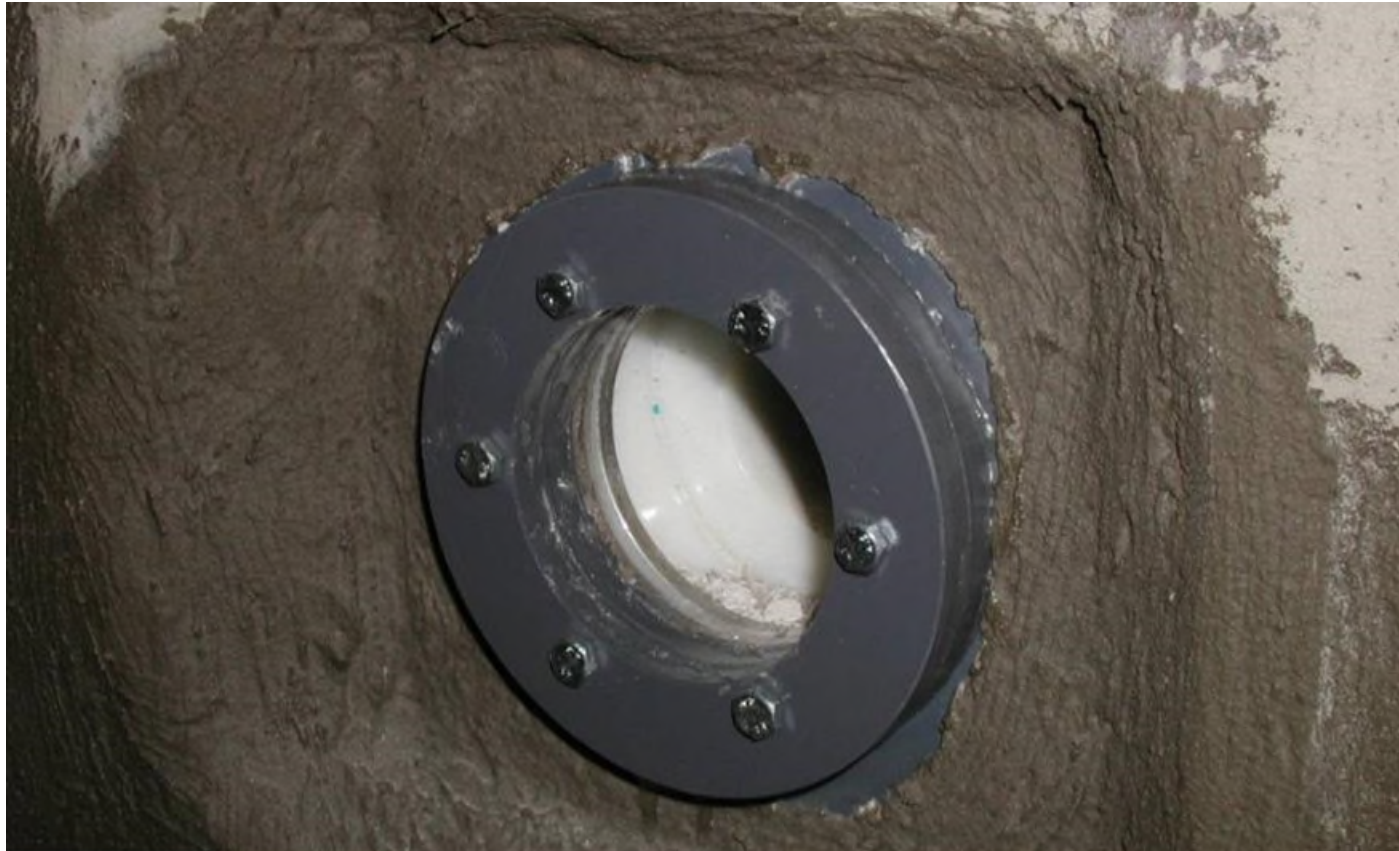
Konstruktion in einem Schwimmbecken
