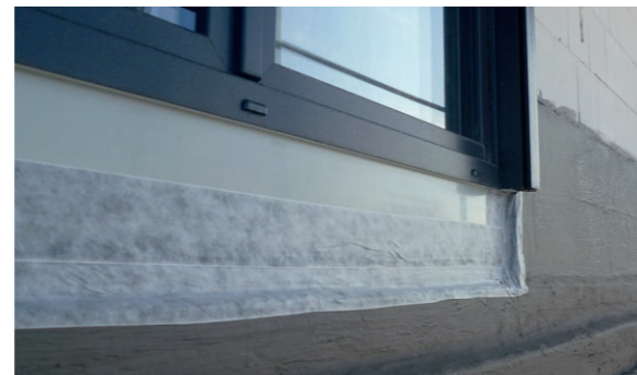
Anschluss Fensterelement mit Fixband PCI Pecithene Fix
