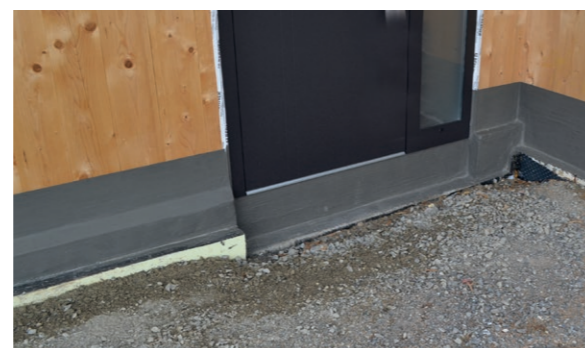
Anarbeiten der flexiblen mineralischen Dichtschlämme PCI Barraseal Turbo an das Dichtband und Fensterelement
