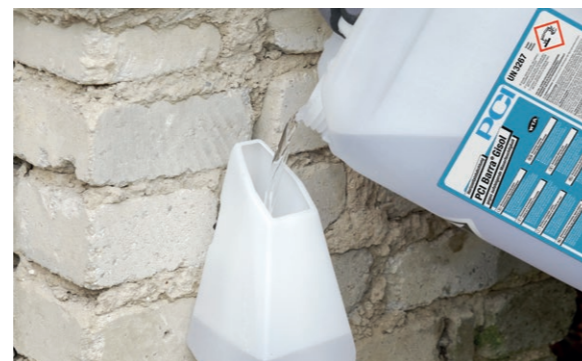
Mauerwerk mit der flüssigen Horizontalabdichtung PCI Barra Gisol gegen aufsteigende Feuchtigkeit schützen
