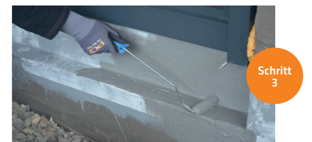
Das eingelegte PCI Barraseal Ready Vlies frisch in frisch mit einer zweiten Schicht PCI Barraseal Ready vollständig überarbeiten.
