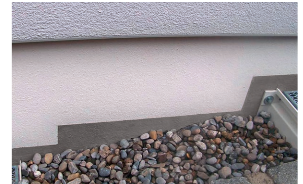
Bauwerksabdichtungen mit PCI Barraseal Turbo können im Sockelbereich so belassen oder überstrichen/überputzt werden
