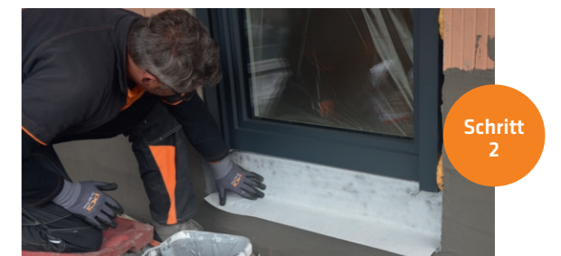
Das PCI Barraseal Ready Vlies vollständig in die noch frische Schicht PCI Barraseal Ready einlegen und vorsichtig andrücken.*
