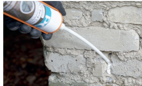
Injektion einer wasserabweisenden Horizontalsperre mit PCI Barra Creme
