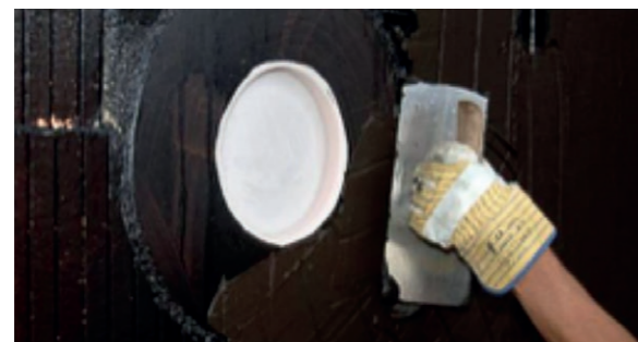
Anarbeiten von PCI Pecimor 2K an einen Klebeflansch
