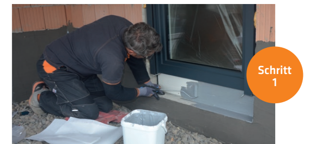
PCI Barraseal Ready mit einer kurzflorigen Rolle oder einem Pinsel flächendeckend auf den vorbereiteten Untergrund aufbringen.
