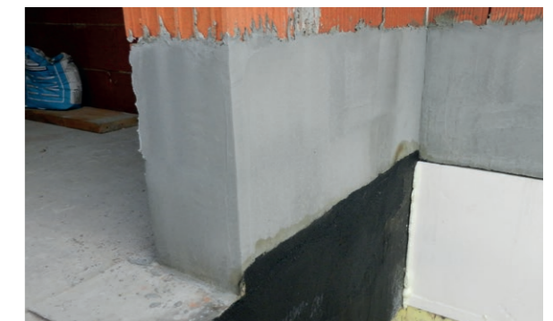
Zwischenabdichtung mit PCI Barraseal
