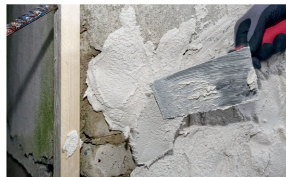
Aufbringen von PCI Saniment 2 in 1 als Sanier- und Feinputz in einem
