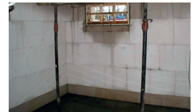
Durchfeuchtetes Kellermauerwerk
