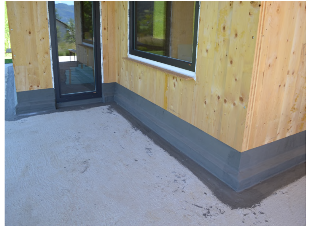
Sockelabdichtung mit mineralischer Dichtschlämme
