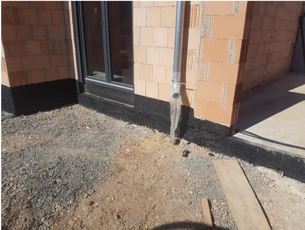
Sockelabdichtung mit Bitumendickbeschichtung
