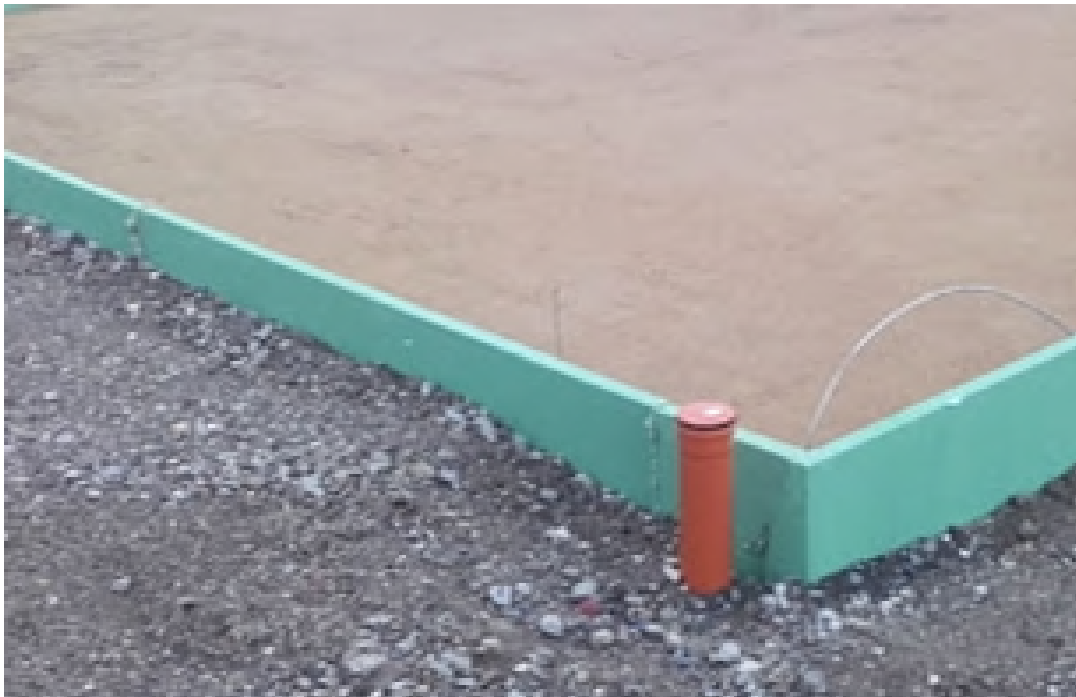
Verlorene Schalung für die Bodenplatte
