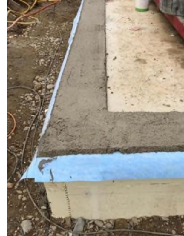
Auftragen der Mörtelausgleichsschicht
