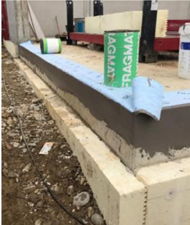
Verkleben von Pecitape 250 an der Stirnseite der Bodenplatte
