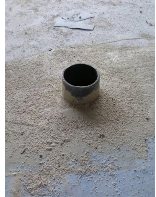
Mit Durchdringung verklebte Dichtmanschette
