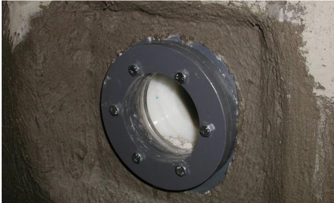
Konstruktion in einem Schwimmbecken
