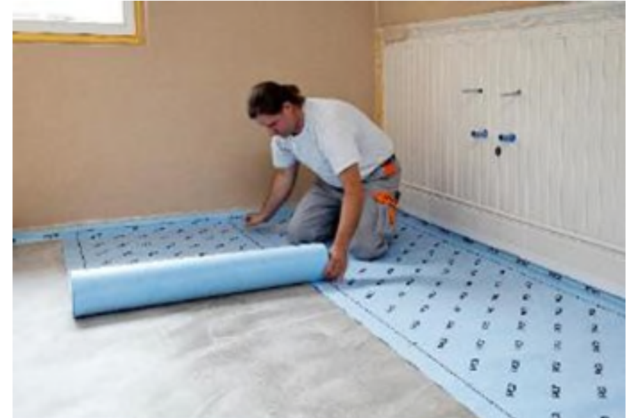
AIV-B: bahnenförmige Abdichtungen Sind ideal bei ebenen Untergründen
